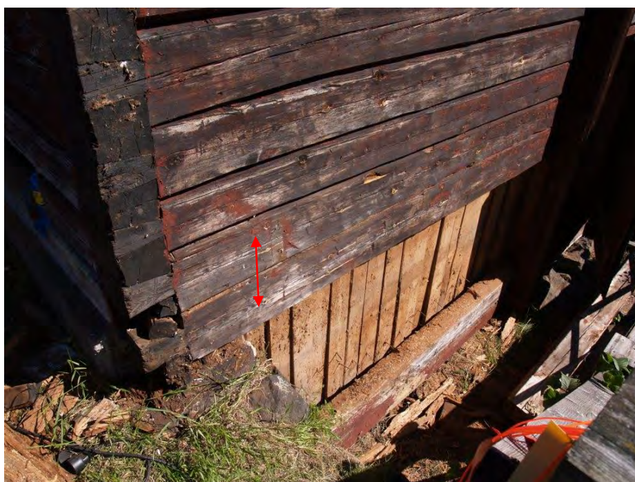
2015-08-19: Förutom de två bottenstockarna D1-D2 kommer nytt timmer att läggas in hela vägen, inklusive de två som markerats med röd pil. Dessa stockar är rötskadade invändigt.
