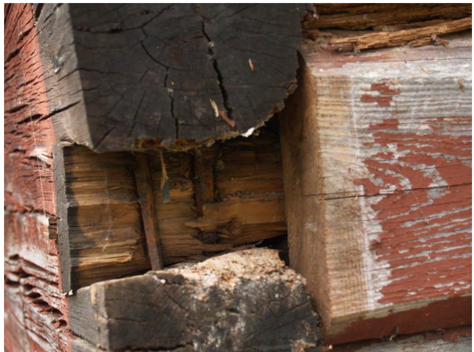
2015-08-12: Spiken är grov och lång och går igen två varv, dvs. två spikar i varje knut.
