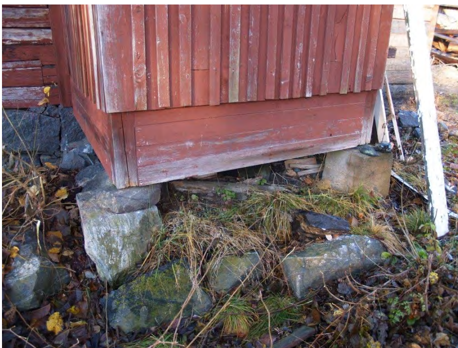
2015-11-11: Kuren har lyfts och rätats. Ovanpå befintliga hörnstenar har mindre stenar lagts in.
