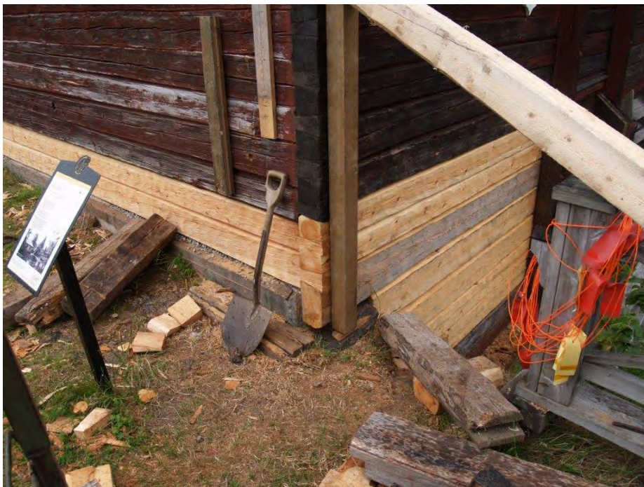
2015-09-02: Rötskadat timmer på gavel D har bytts ut.
