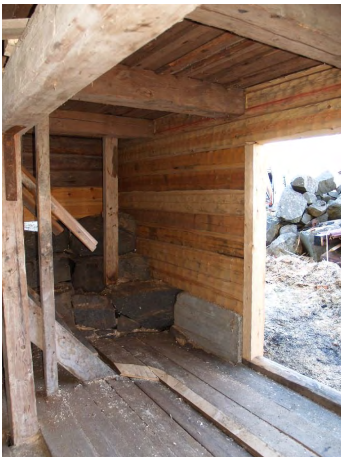
2015-11-11: Dörrgåtorna nytillverkades, och nästa år ska dörrbladen återmonteras.
