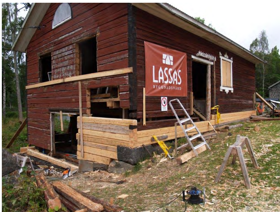
2015-09-02: De svåraste delarna har nu genomförts och bottenstockarna är på plats.
