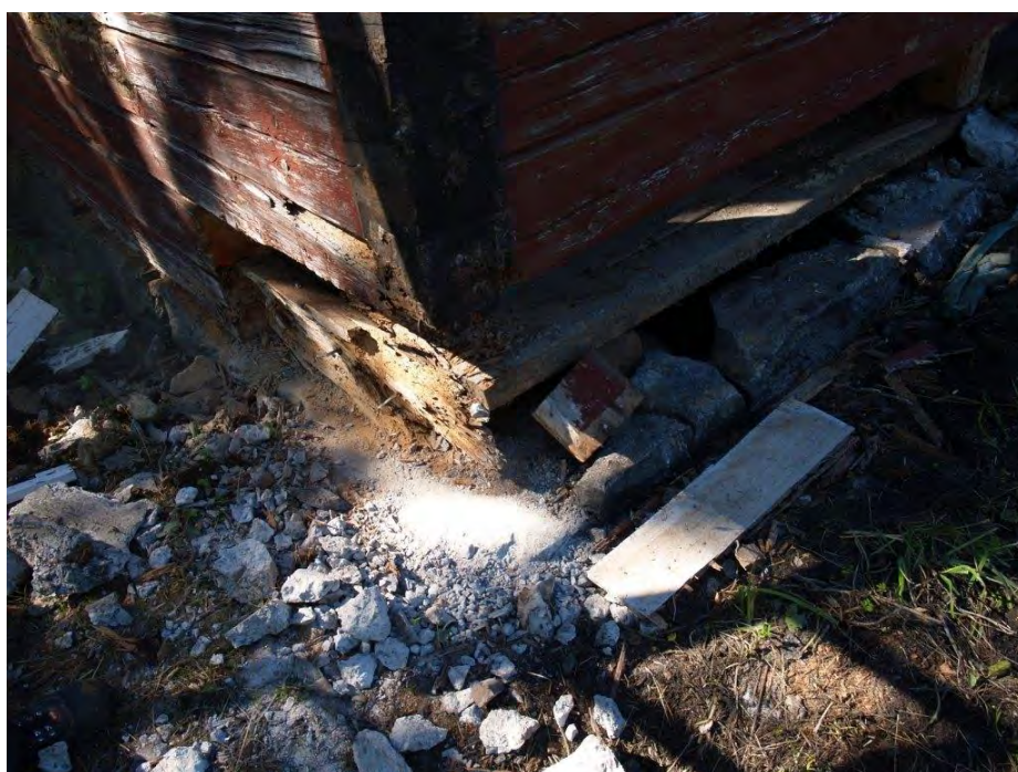
2015-08-19: När lös sten tagits bort ser man att grunden är anpassad efter timret eftersom stensockeln är ett halvt timmervarv högre på B än på C.
