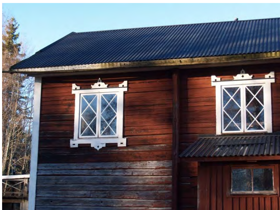
2015-11-11: De ny tillverkade bågarna är monterade på långsidan C.
