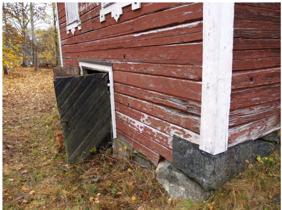
2014-10-16: Under hörn AB finns stengrunden kvar.
