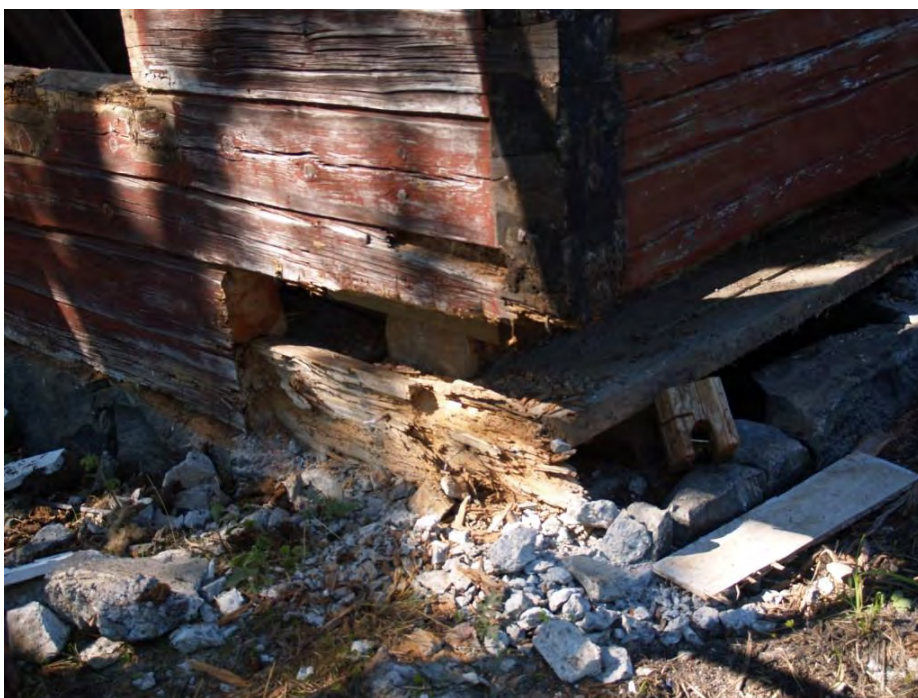
2015-08-19: I hörn BC har betongsockeln tagits bort.
