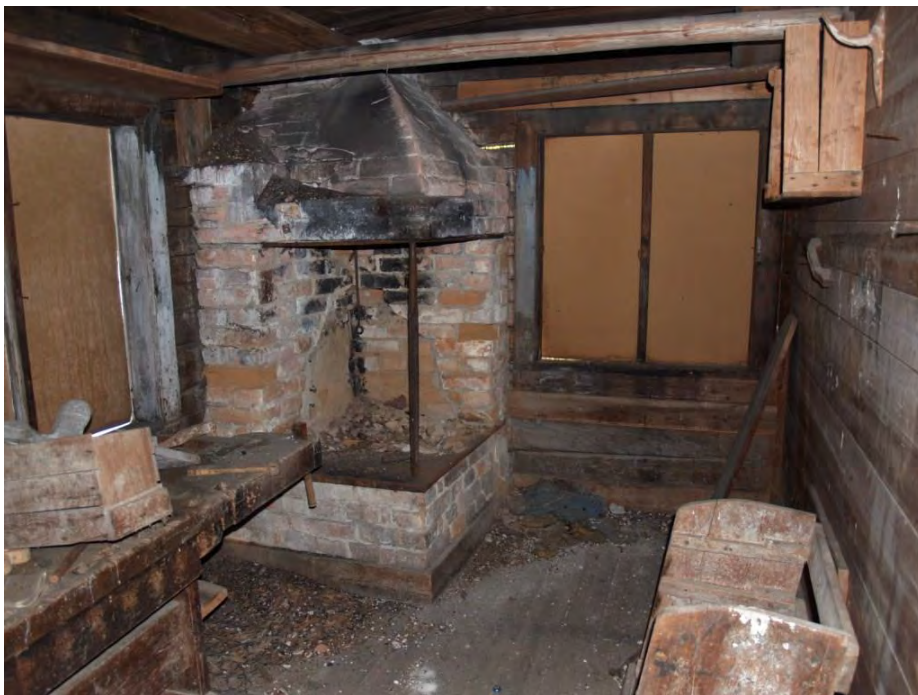
2014-10-16: Teglet i den öppna spisen vittrar sönder till pulver och putsen släpper från kåpan.
