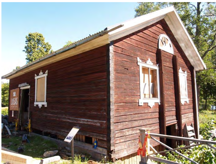
2015-08-19: Timret på gavel D, mot hörn DA, har frilagts och tagits loss.
