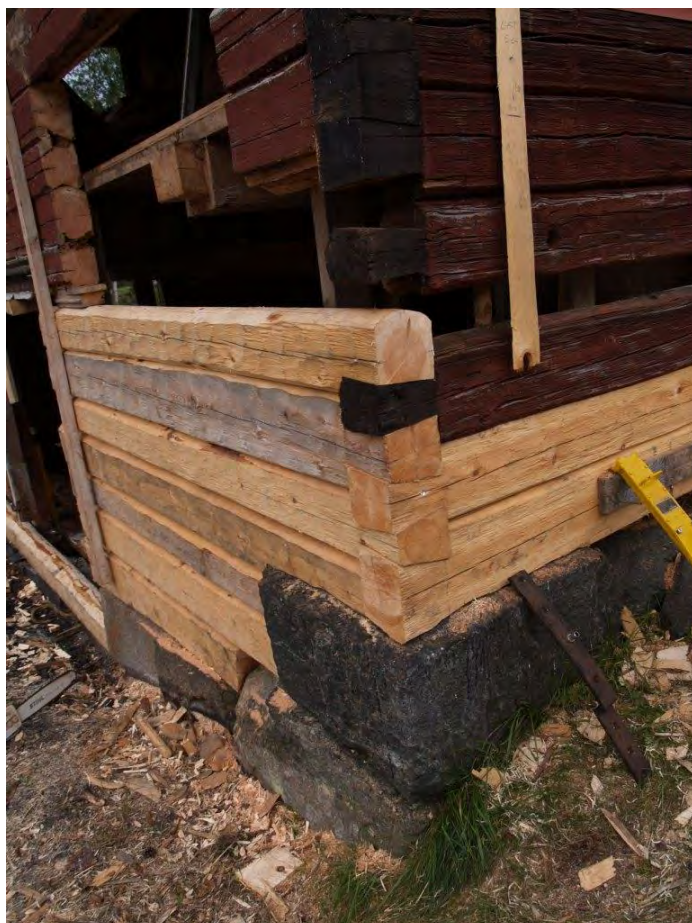
2015-09-02: Timret knutas in med samma typ av knutar som befintliga.
