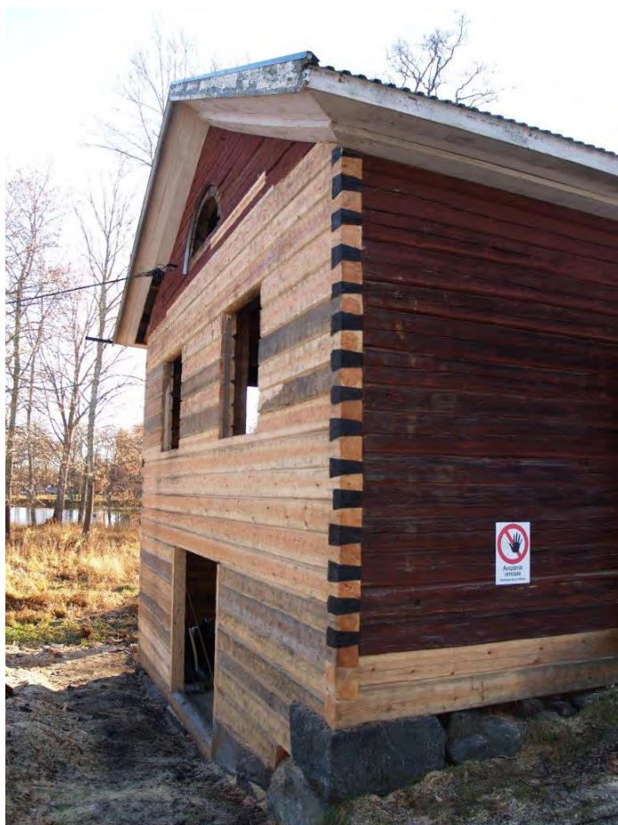
2015-11-11: Under vintern och våren får stommen möjlighet att sätta sig och torka ihop och därefter monteras karmar, följare m.m.
