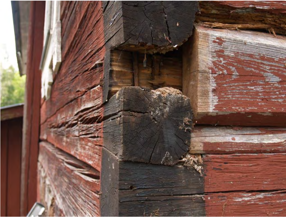
2015-08-12: En negativ överraskning var knutarnas spikning.
