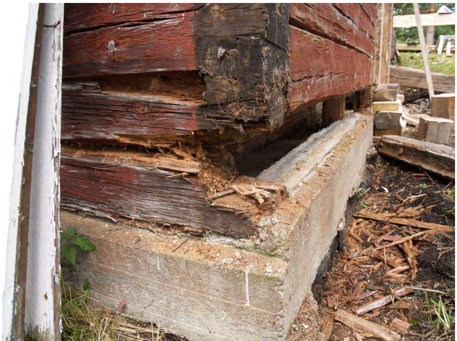
2015-08-12: Betongen tas bort och ersätts med timmer.
