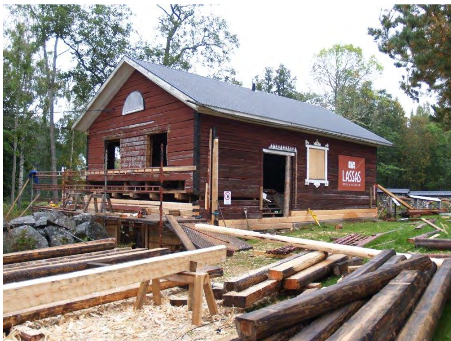
2015-09-23: Förhoppningsvis har de mest komplicerade delarna av timmerbytena klarats av. Nu återstår byte av timmer i väggen från mellanbjälklaget och uppåt.
