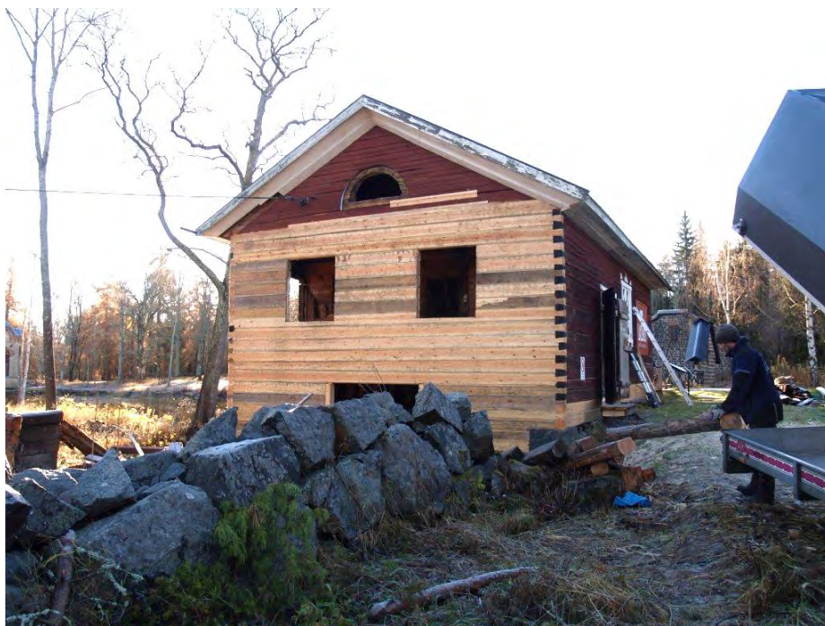
2015-11-11: Etapp 1 har avslutats och stommen är hel.
