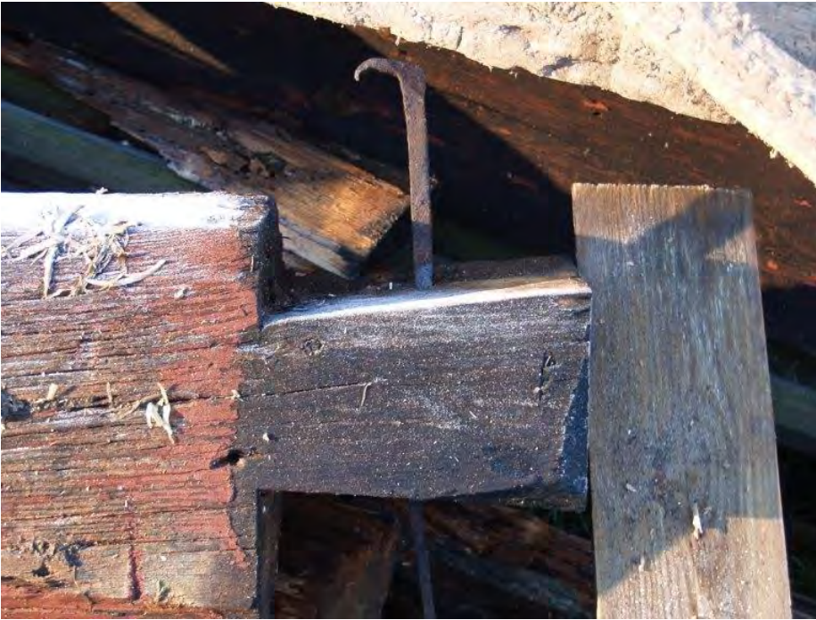
2015-11-11: Det var både spikar och hakar i knutskallarna.
