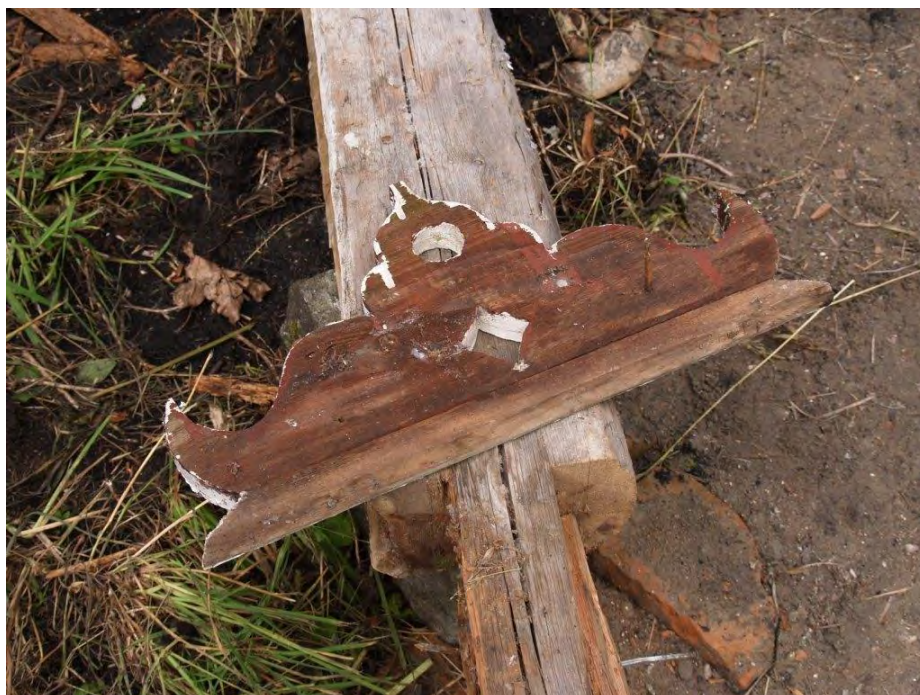
2015-08-12: Virket är återanvänt med rödfärg och ramsågad yta på baksidan.
