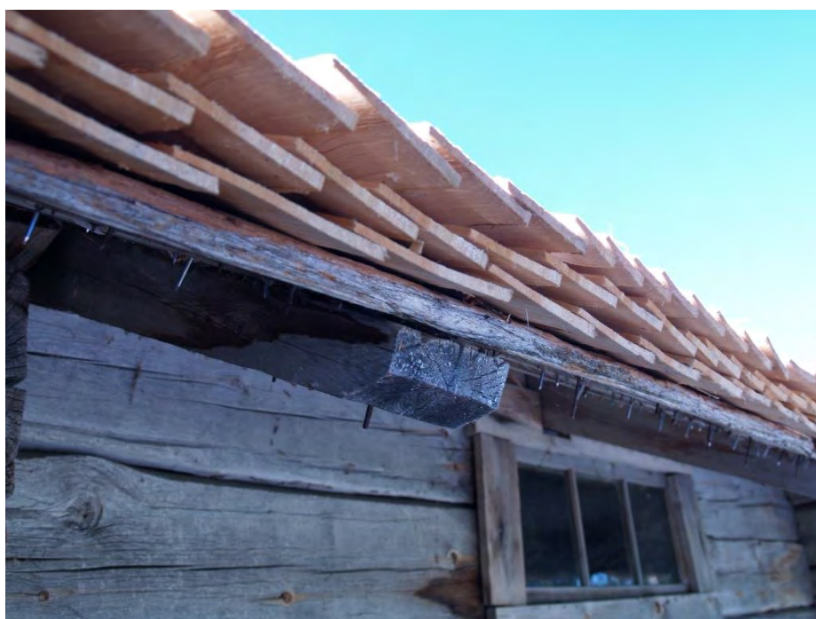
2015-07-03: Det nya spånet är handspäntad fura, 54 centimeter lång, som har lagts i tre lager från vänster till höger med knivsidan ner.
