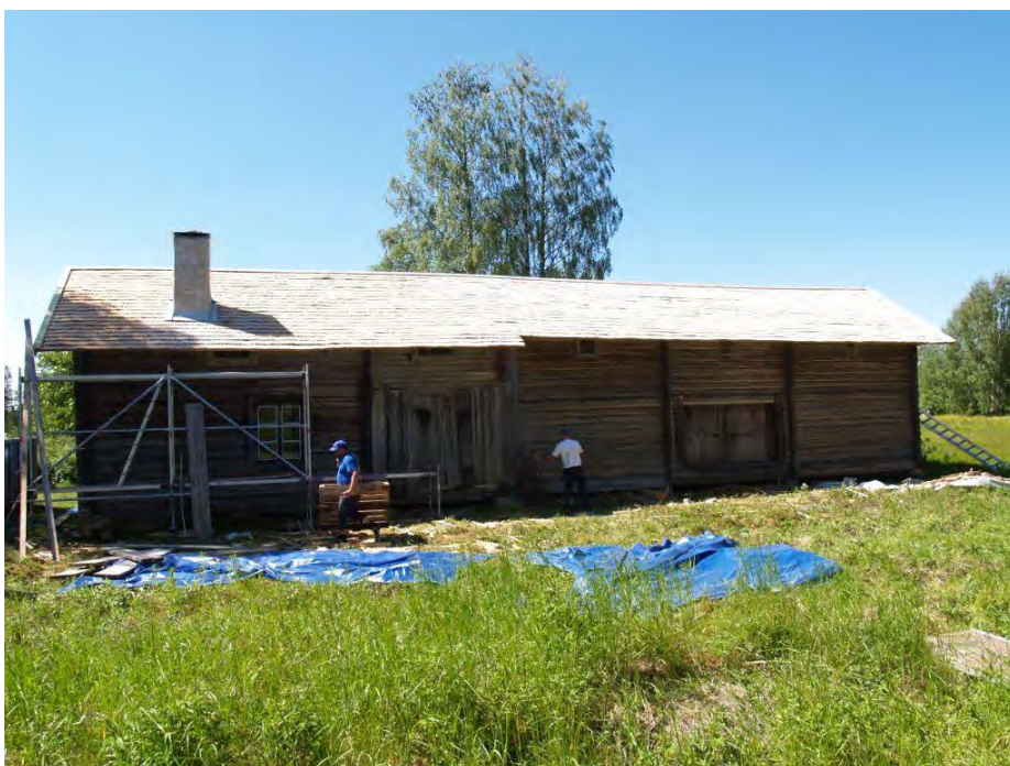
2015-07-03: Baksidans takfall har lagts om med ca 10 000 nya handspäntade takspån.
