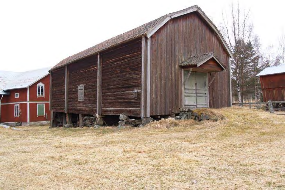
2012-04-23: Trösklogen med tegeltak.
