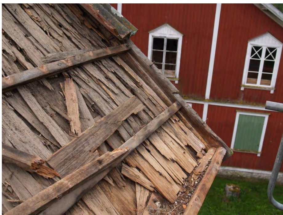
2015-09-01: Pannorna hängde på en bärläkt medan ströläkt saknades. Läkten var 3,5 x 2,5 cm och klingsågad. Läkten var spikad med 4 tums blank trådspik.
