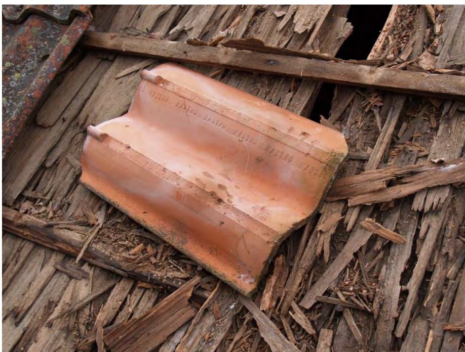
2015-09-01: Tegelpannorna är stämplade med Hästbo (tegelbruk i Torsåker, Gästrikland). Pannorna är 42 cm långa, 28,5 cm breda med en klacklängd på 4,5 cm.
