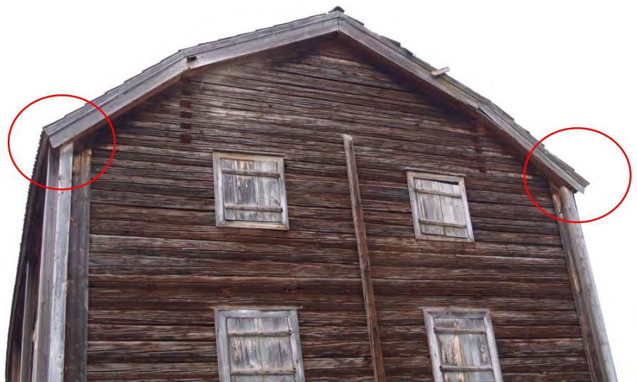
2012-04-23: Teglet gick ut över vindskivorna så att vattbräddor inte behövdes.
