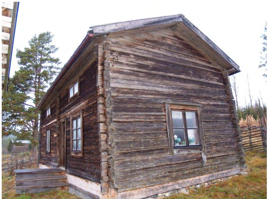
2013-11-01: Vindskivor och vattbrädor kommer också att bytas.
