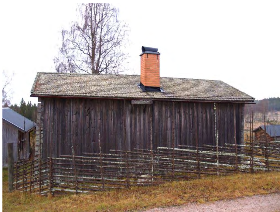
2013-11-01: Skorstenen är ommurad och har försetts med svartlackerade beslag.
