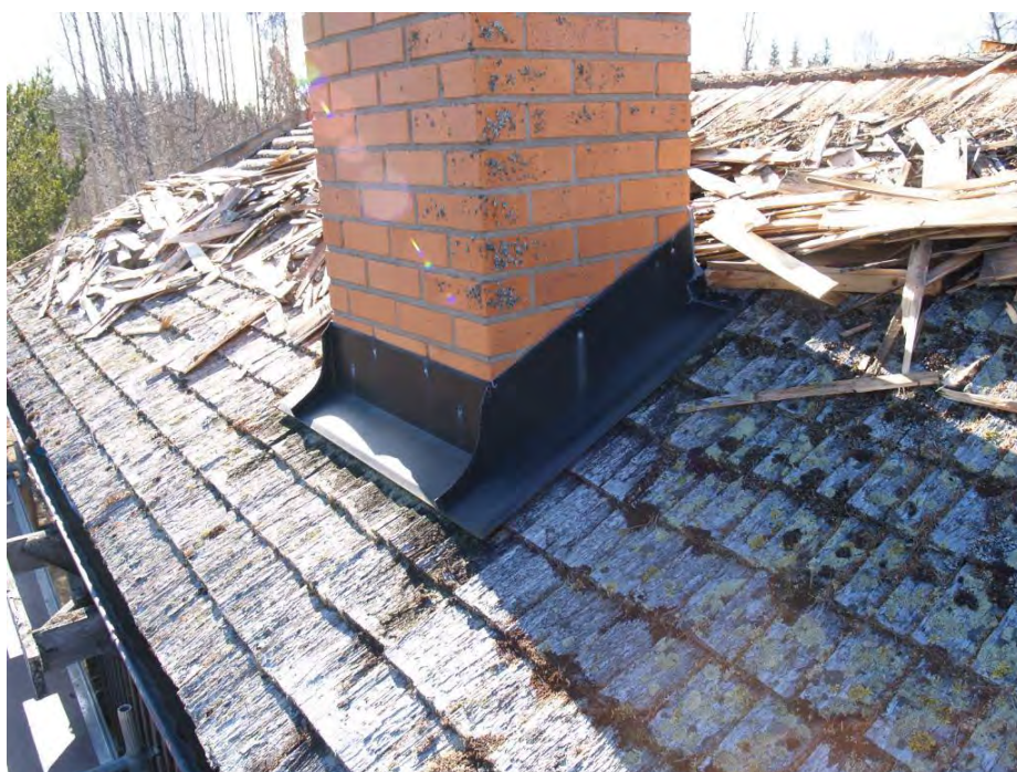
2015-04-21: Befintligt nedre skorstensbeslag.
