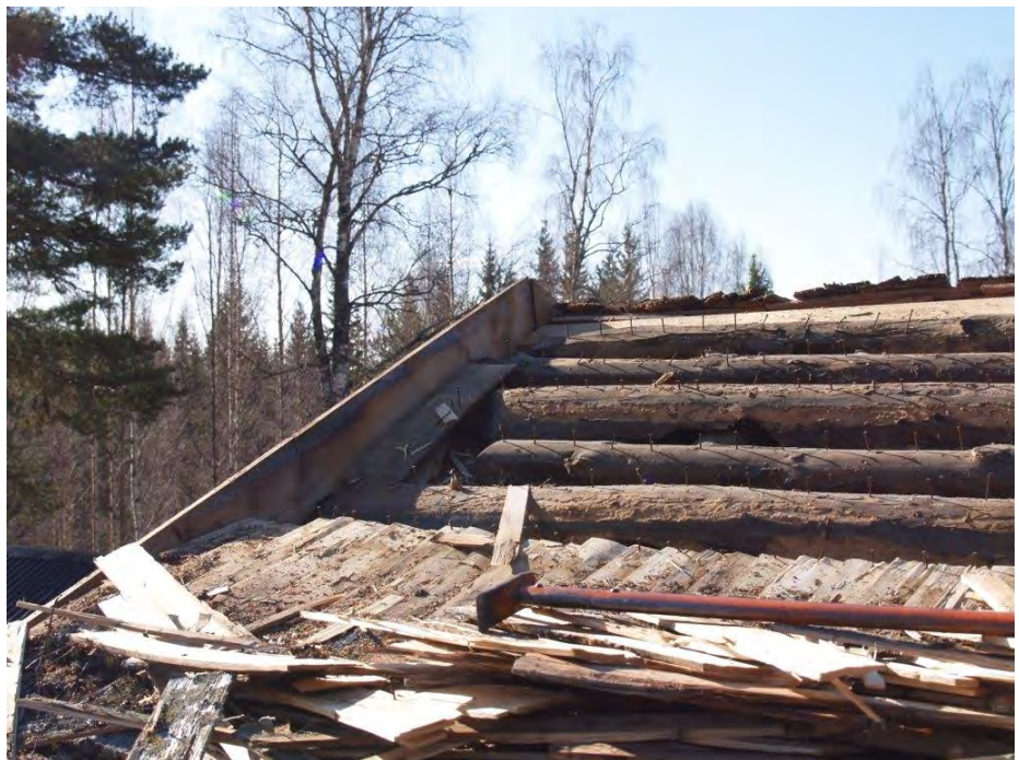
2015-04-21: Spånen var spikade med galvspik, som inte följer med när spånet skottas bort.
