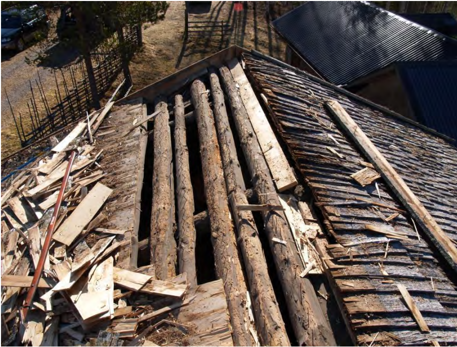
2015-04-21: Spånen har spikats på en tro av kluvor.
