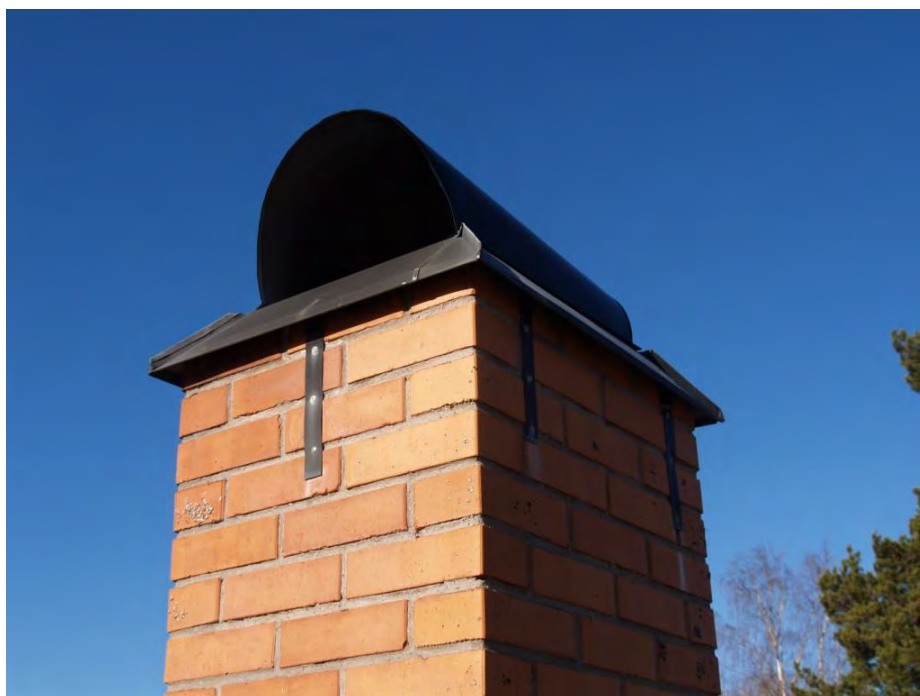
2015-04-21: Skorstenen har vid något tillfälle murats om och försetts med nya beslag.
