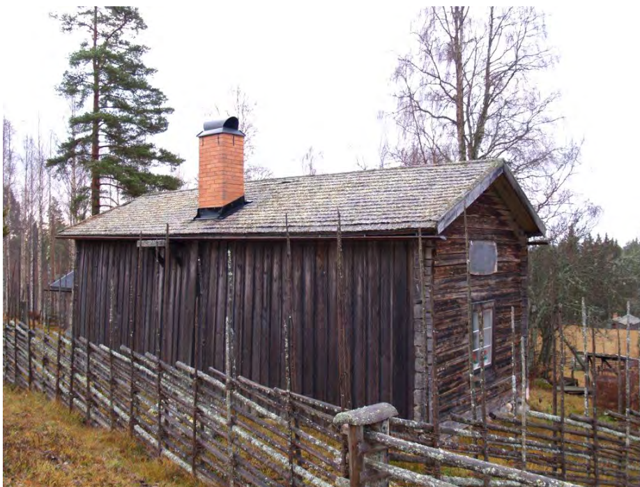
2013-11-01: Takspånet är bevuxet med mossa och lavar. En hängränna sitter på baksidan.
