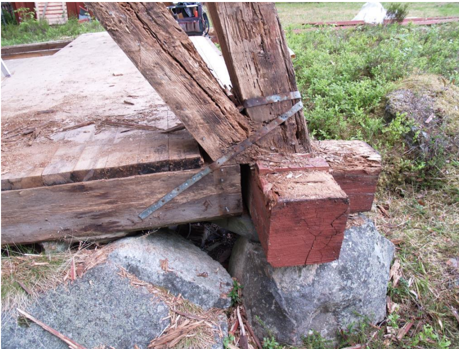
2016-06-09: Hörn BC. Hörnstolpen har genomgående röta och byts ca en meter. Snedsträvan har angripits av myror och är delvis uräten.
