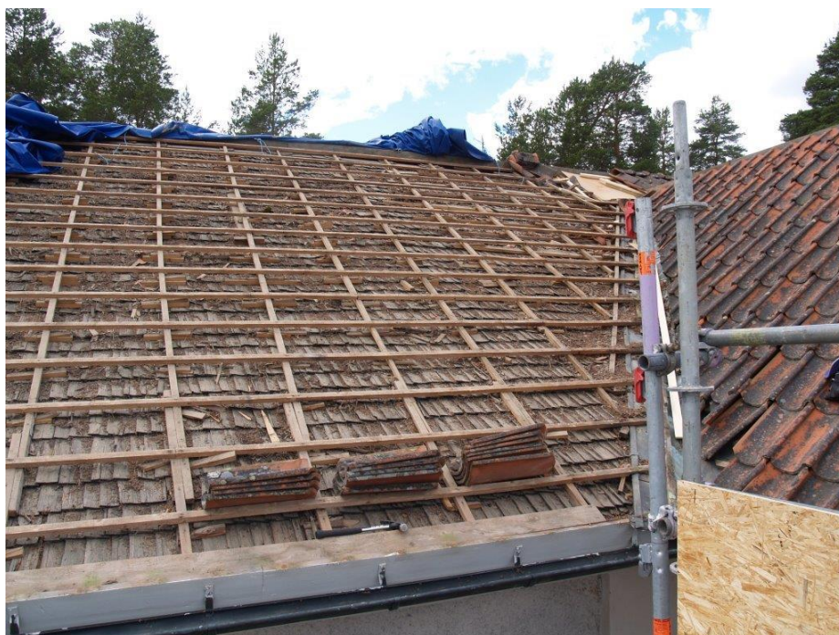
2016-07-05: Omläggning pågår på takfallet mot D.
