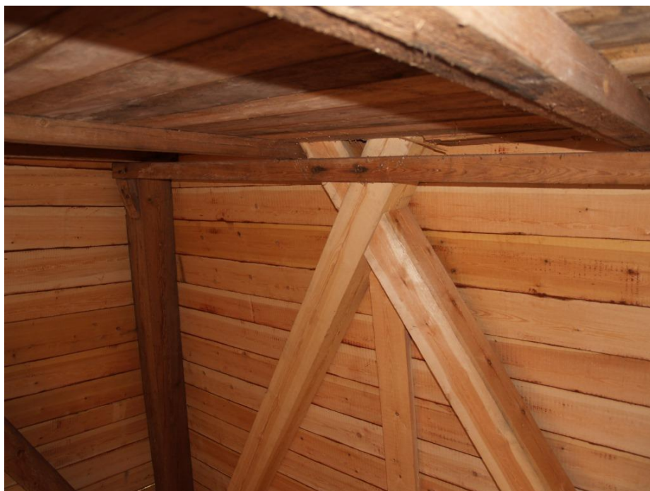
2016-07-15: Strävorna där de går igenom mellanbjälklagets golv.
