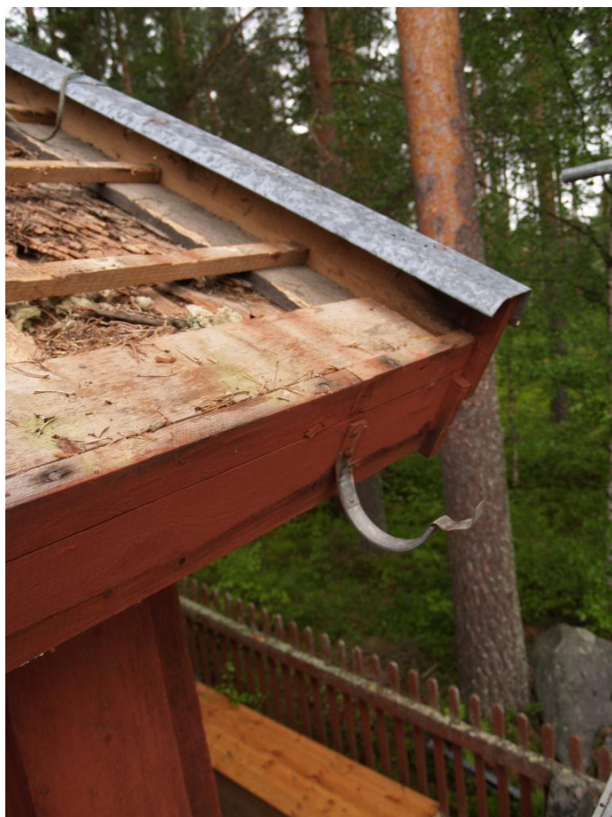
2016-06-21: Rännkrokar på framsidan. Galvaniserade vattplåtar, falsade i korta längder.
