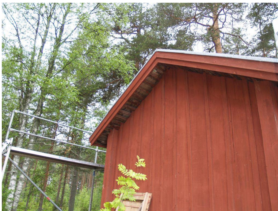
2016-06-21: Gavlarna har dubbla vindskivor, en för spåntaket och en övre som tillkom med tegeltaket.
