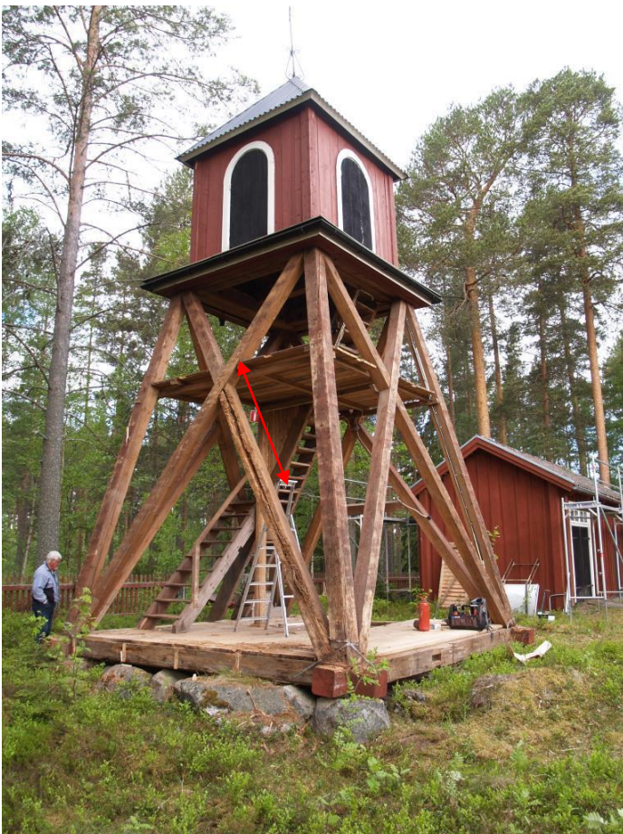
2016-06-09: Snedsträvan är ihålig på mitten och måste bytas. Den övre delen är frisk och kan användas som lagningsvirke.
