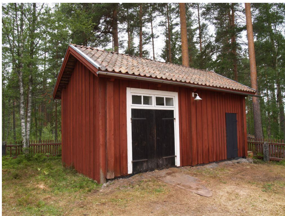
2016-07-15: Taket mot A är omlagt med återanvända tegelpannor.
