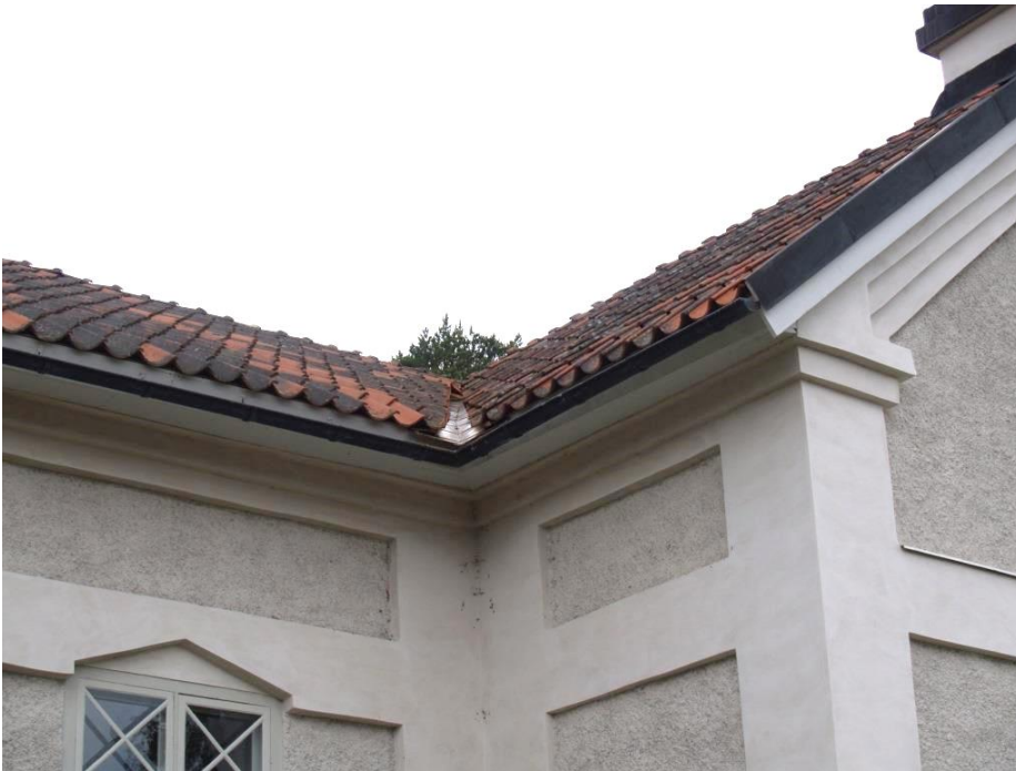
2016-07-15: Den breddade ränn dalen ska förhoppningsvis bidra till att takpannorna inte går sönder i samma utsträckning.
