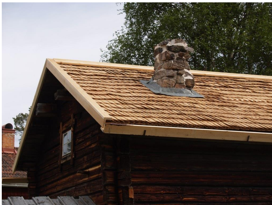
2017-06-15: Skorstensplåten återanvändes. Lösa stenar i skorstenens krön har murats fast med kalkbruk.
