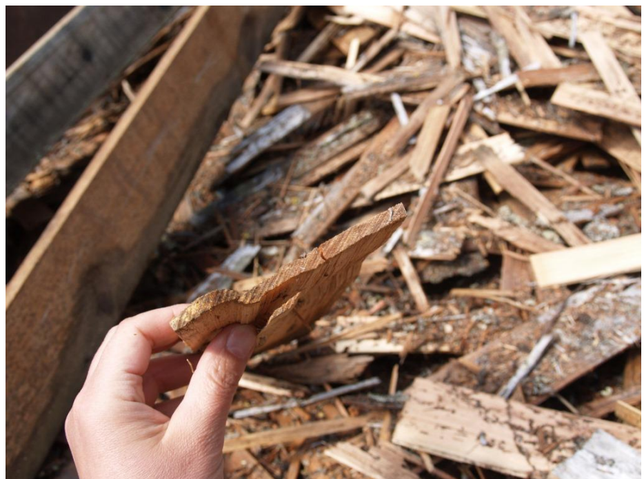
2017-05-31: Det gamla taket var lagt i tre lager med knivsidan nedåt. Virkeskvaliteten var god och spånen förhållandevis rektangulära.
