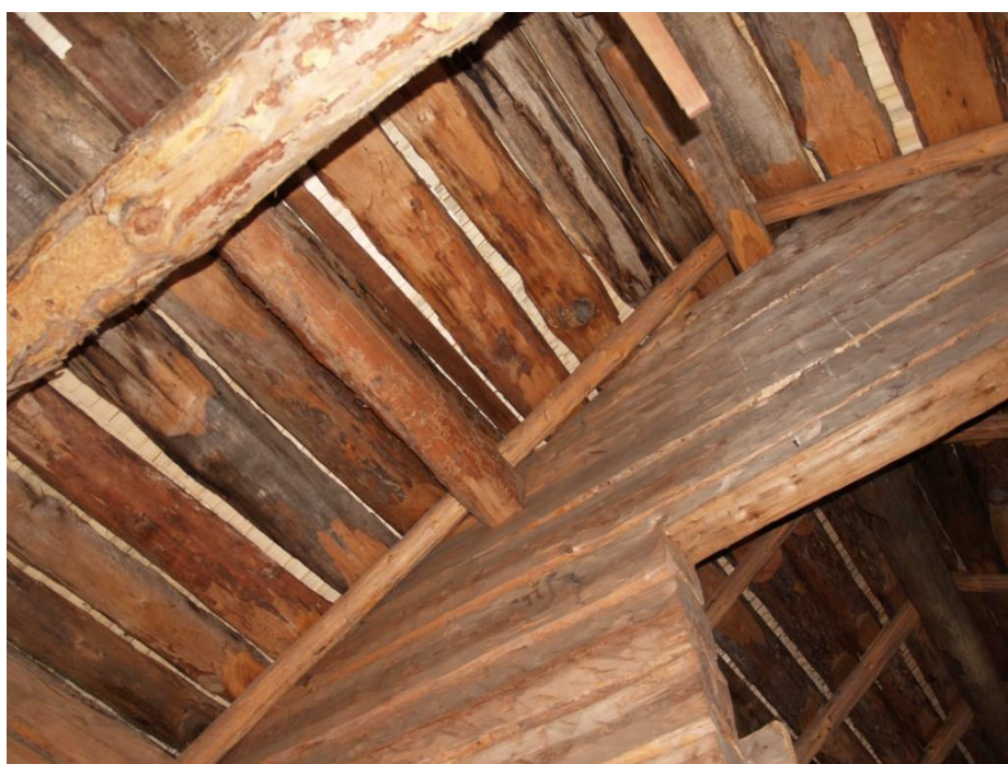
2017-06-15: Snickarbodens gavelröste. Det nya spånet syns som ljusa band mellan trobräderna.
