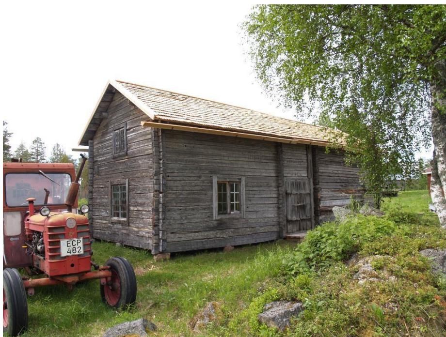
2017-06-15: Taket efter färdigställandet.
