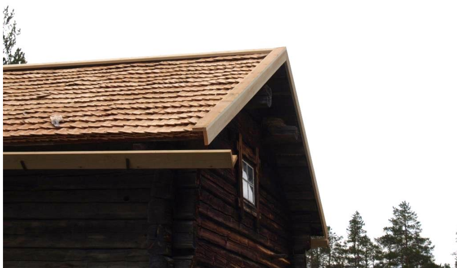
2017-06-15: Nock- och vattbrädor är utbytta liksom vindsnivorna. Nya trärännor, lika befintliga, har satts upp i rännkrokarna.
