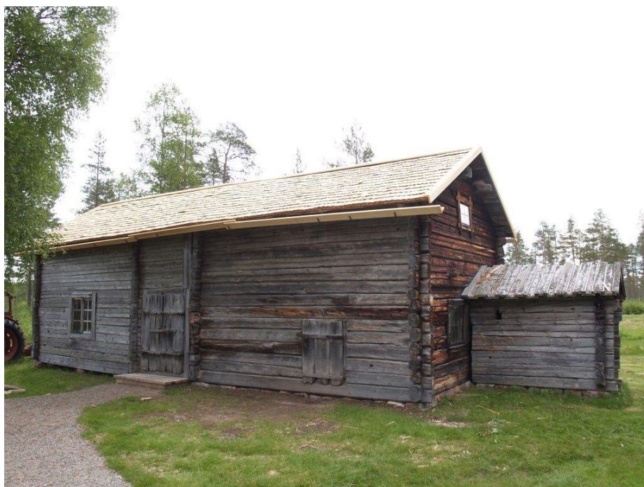
2017-06-15: Spåntaket är omlagt.
