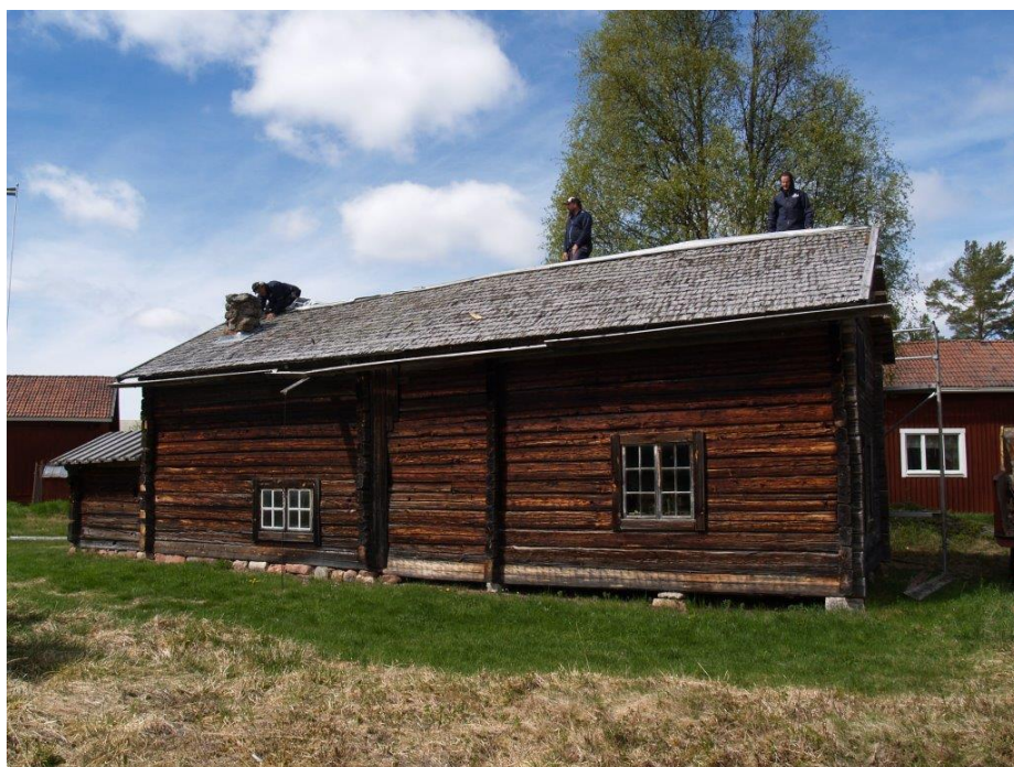
2017-05-31: Södra takhalvan ska åtgärdas härnäst.
