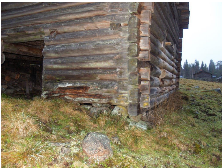
2019-11-22: Rundtimmerstockarna D1 och D2 hade rötskador och byttes ut när arbeten med grund och stomme ändå skulle göras.
