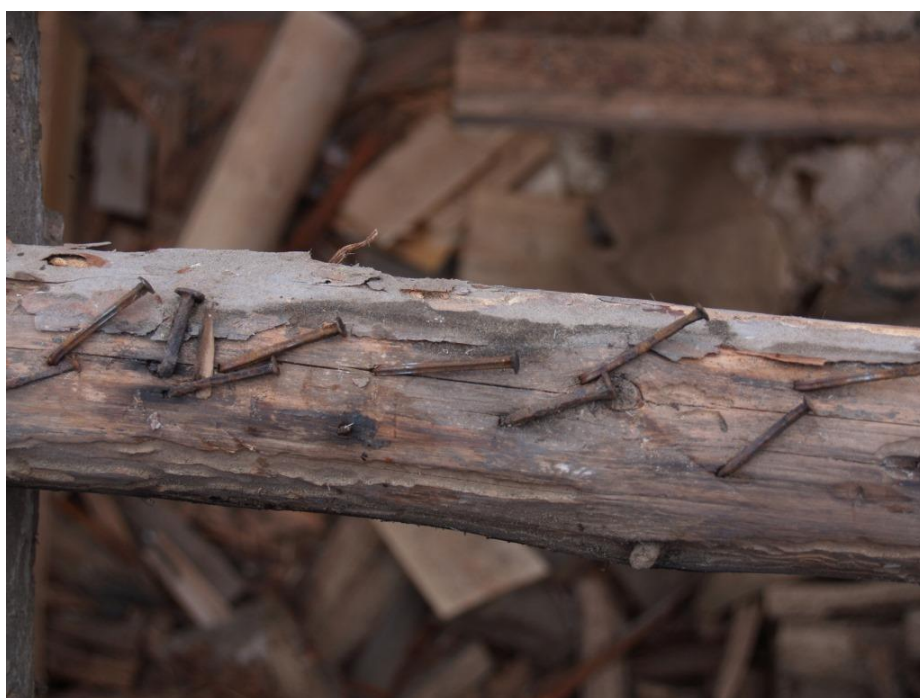
2020-09-15: Två lager trådspik kan ses men också rester av klippspik. Det är möjligt att det har legat tre generationer spån på taket och att vi nu lägger det fjärde.
