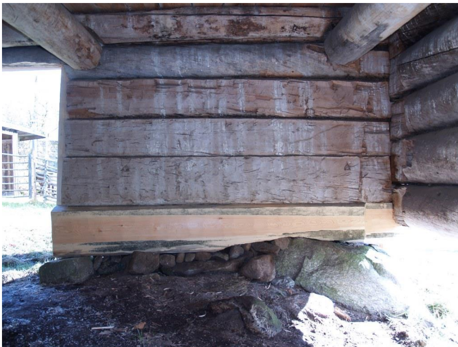
2020-10-08: Slutbesiktning Den utbytta stocken stämmer bättre i dimension med den befintliga väggen. Stocken är färsk och därför har det blivit viss blånad i ytveden men det påverkar inte hållbarheten.
