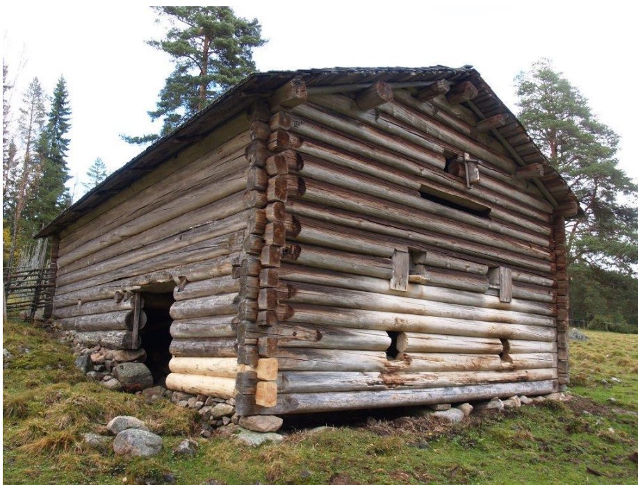
2020-10-08: Slutbesiktning Hagas fäx efter att stomme och grund har åtgärdats.
