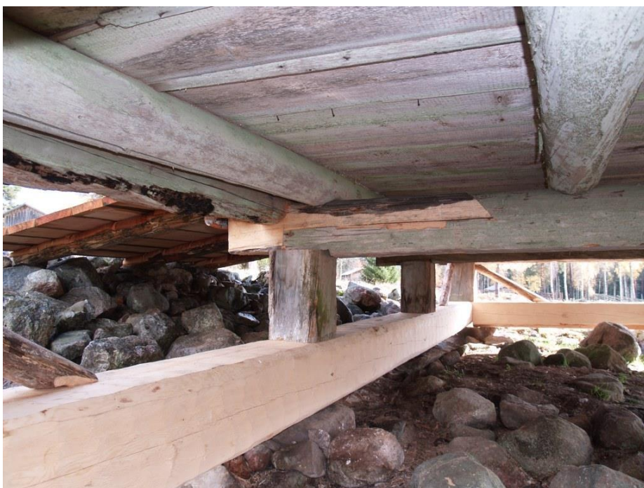
2020-10-08 : Slutbesiktning Skarv i bärlina. Skarven har fästs med genomgående trädymlingar som har kilats.
