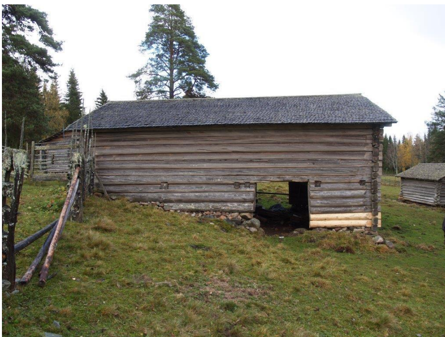
2020-10-08: Slutbesiktning Långsida D efter åtgärd.
