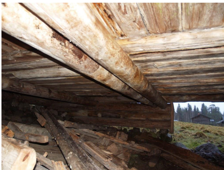
2019-11-22: Mellanbjälklaget sett underifrån.
