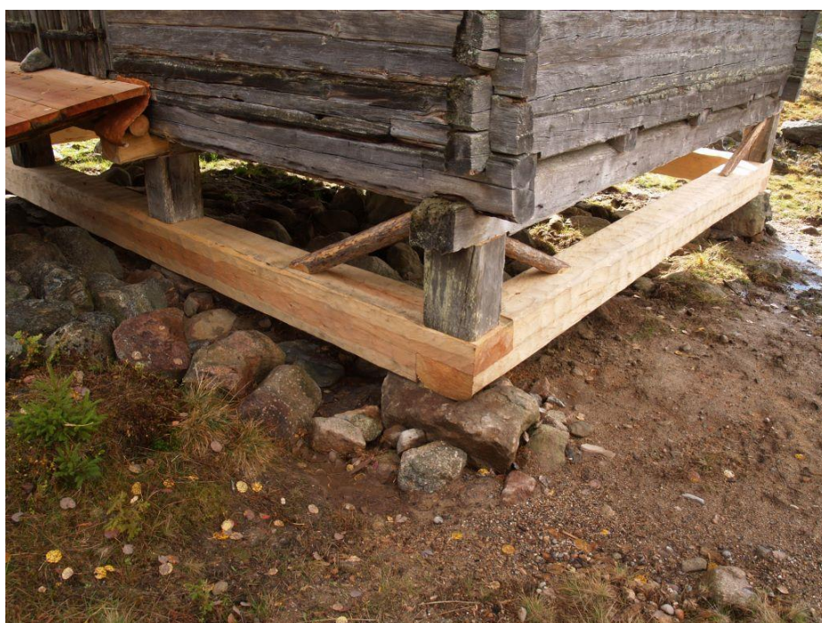
2020-10-08 : Slutbesiktning I hörn AB och DA har småsten innesluten i markduk grävts ned som bärlager. Ovanpå står nya grundstenar.
