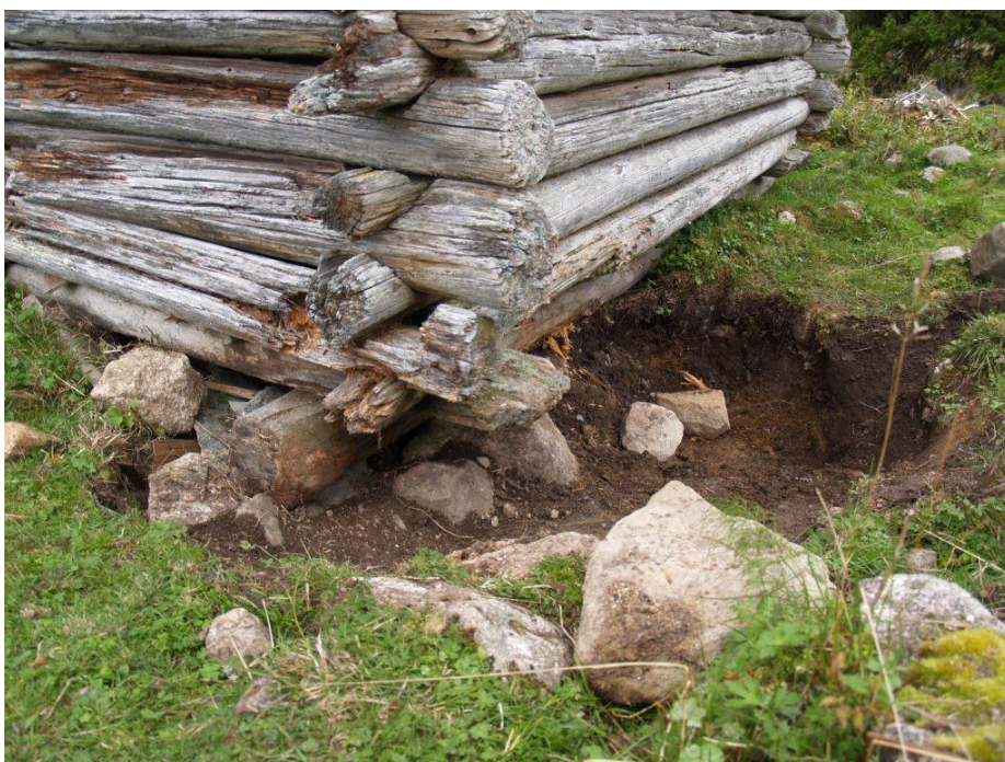
2020-09-15: Grunden på Hagas lada grävdes fram. Den stora stenen som stommen hängt upp sig på hade vid besökstillfället flyttats för att ingå i grunden under fäxet.
