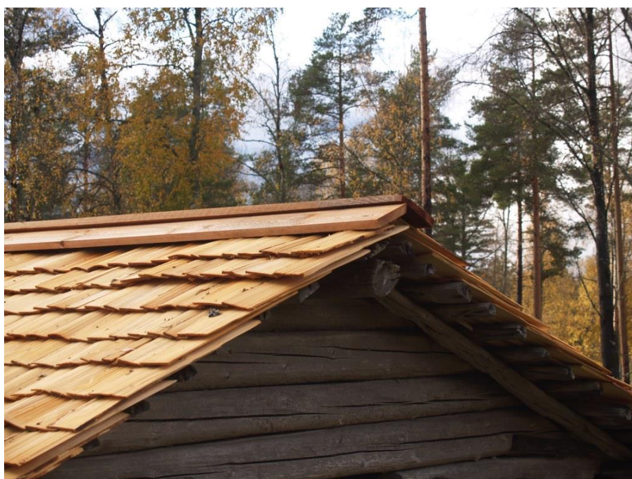
2020-10-08: Slutbesiktning Nya nockbrädor.
