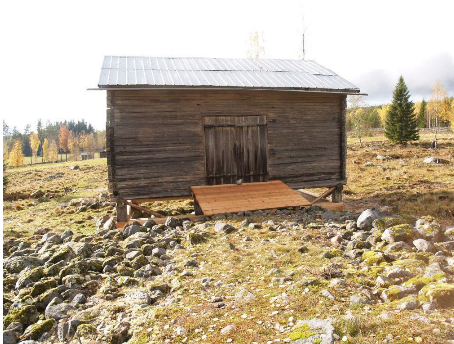
2020-10-08: Slutbesiktning Lassas loge efter färdigställandet.
