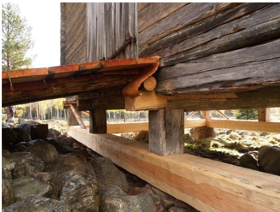
2020-10-08 : Slutbesiktning Ny uppkörsbro. Kärnan har vänts uppåt.
