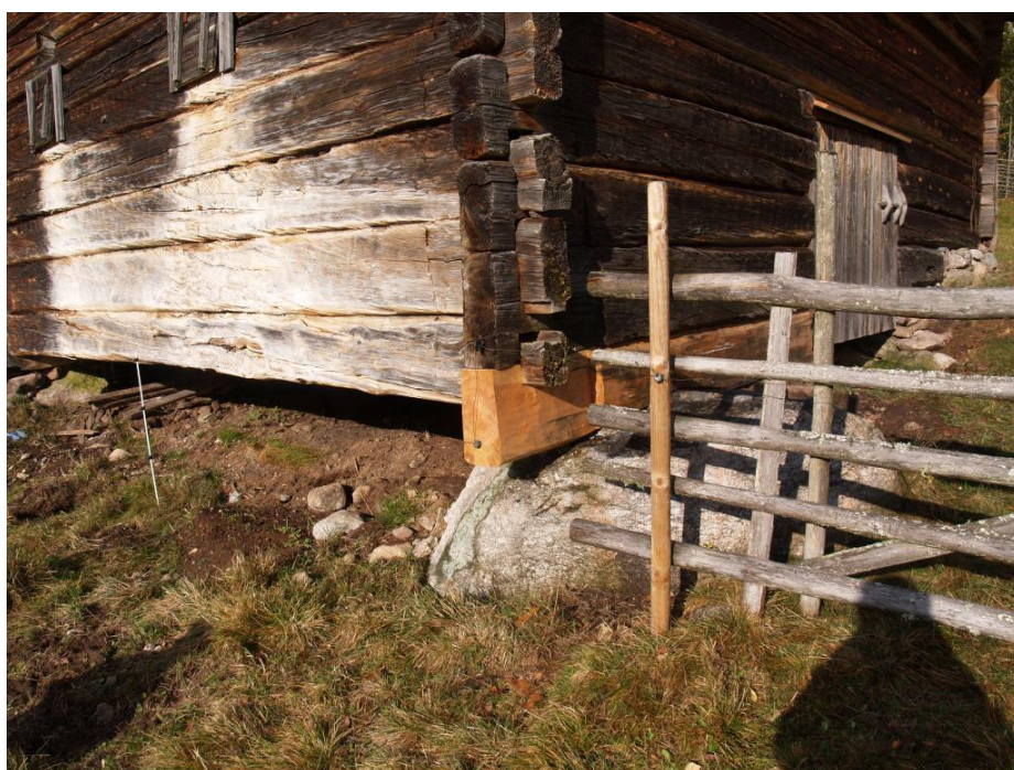
2020-10-08: Slutbesiktning Syllen har bytts ut till en grövre timmerstock.
