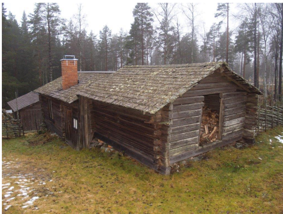
2019-11-22: Vedboden, det gamla rökstösset, var i behov av nytt spåntak.
