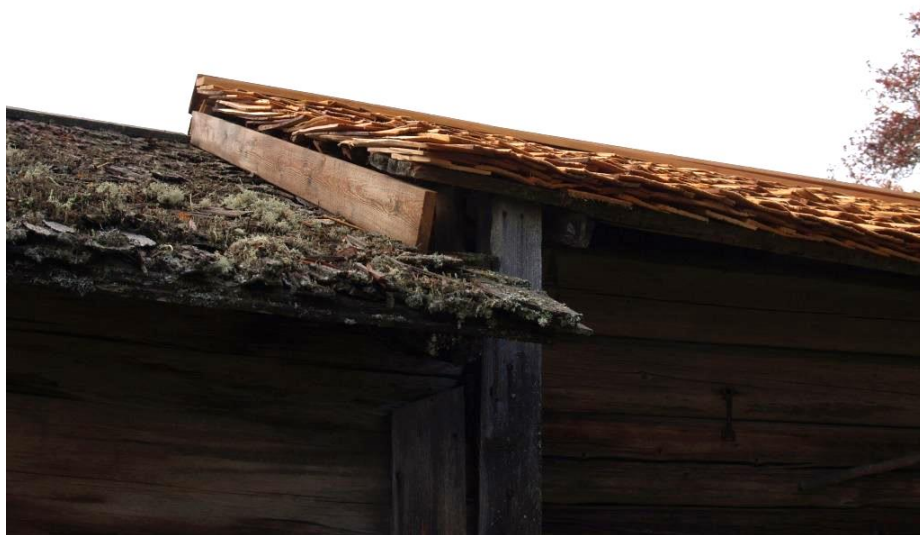
2020-10-08: Slutbesiktning Vindskivan vid stössets tak är nu möjlig att ta loss eftersom spånen inte är spikade i den.
