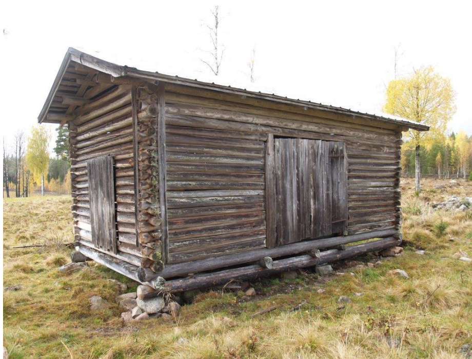
2020-10-08: Slutbesiktning Ladan har lyfts och placerats på nya hörnstöd.
