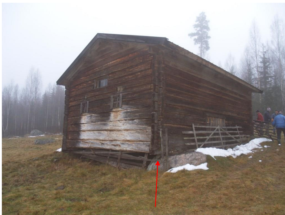
2019-11-22: Lassas fäx med hörn BC där syllen byttes ut.
