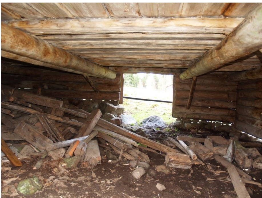
2020-10-08: Slutbesiktning Stagen på långsida B som ska hålla väggen på plats framöver. Öppningarna kommer att spärras av så att djuren inte kan gå in under fäxet.
