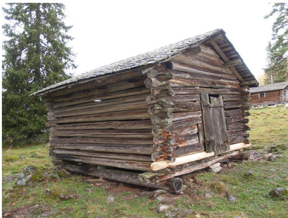
2020-10-08: Slutbesiktning Ladan har lyfts och rätats. Tröskelstocken har bytts ut.
