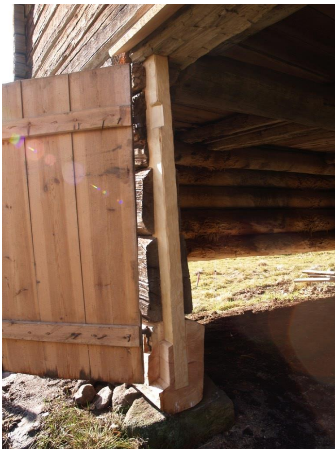
2020-10-08: Slutbesiktning Den utbytta stocken stämmer bättre i dimension med den befintliga väggen. Stocken är färsk och därför har det blivit viss blånad i ytveden men det påverkar inte hållbarheten.
