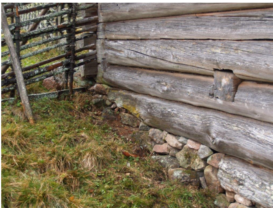
2020-10-08: Slutbesiktning Fåxets hörn DA har fått en översyn. Jord nära syllen har tagits bort och stenar lagts in under timret för att förhindra att fukt orsakar röta.
