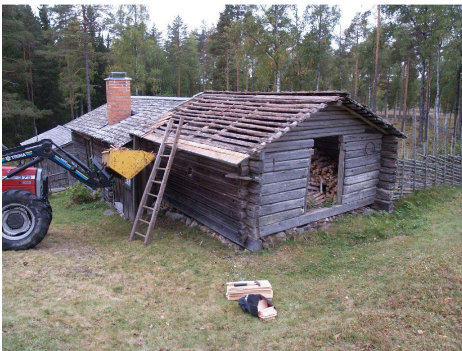
2020-09-15: Omläggningen av taket på vedboden, det f.d. rökstösset, under pågående arbete.
