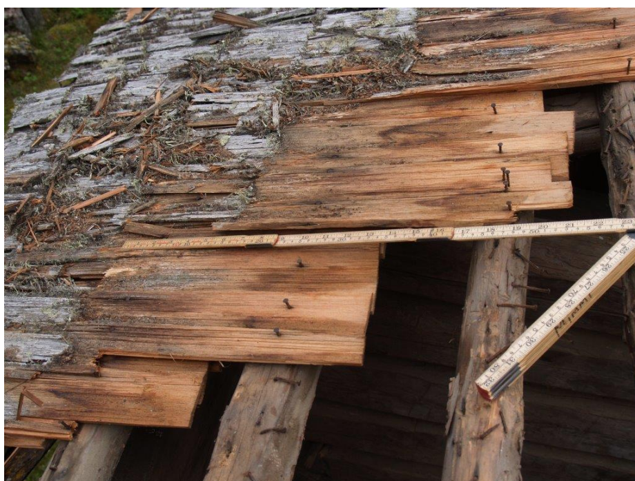
2020-09-15: Befintlig späntak lades 1976 av tidigare ägargeneration. Det var handspäntad furu. Virket var torraka tagen vid det egna skogsskiftet på Slummeråsen, Svartjärnsberget. Liggande stammar letades upp och togs hem för spåntillverkning. Spånet var 21", ca 54 cm långt, och låg i tre lager. Takfoten hade tvålagstäckning. Spånen var spikade från höger till vänster. Kärnan överlappade ytveden.
