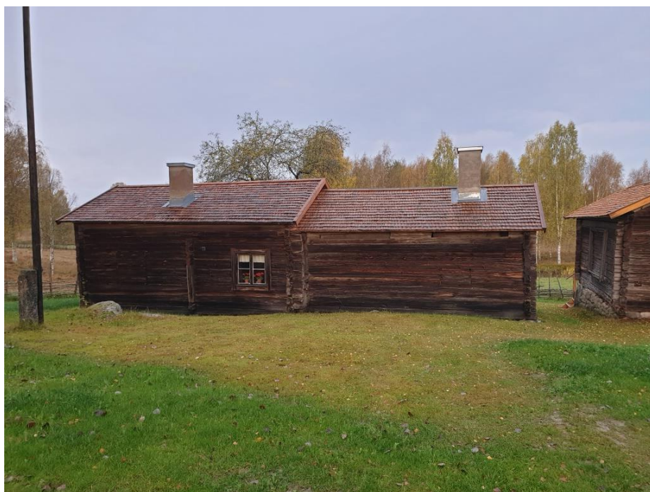
2020-10-07: Slutbesiktning Omlagda tak och lagade skorstenar.
