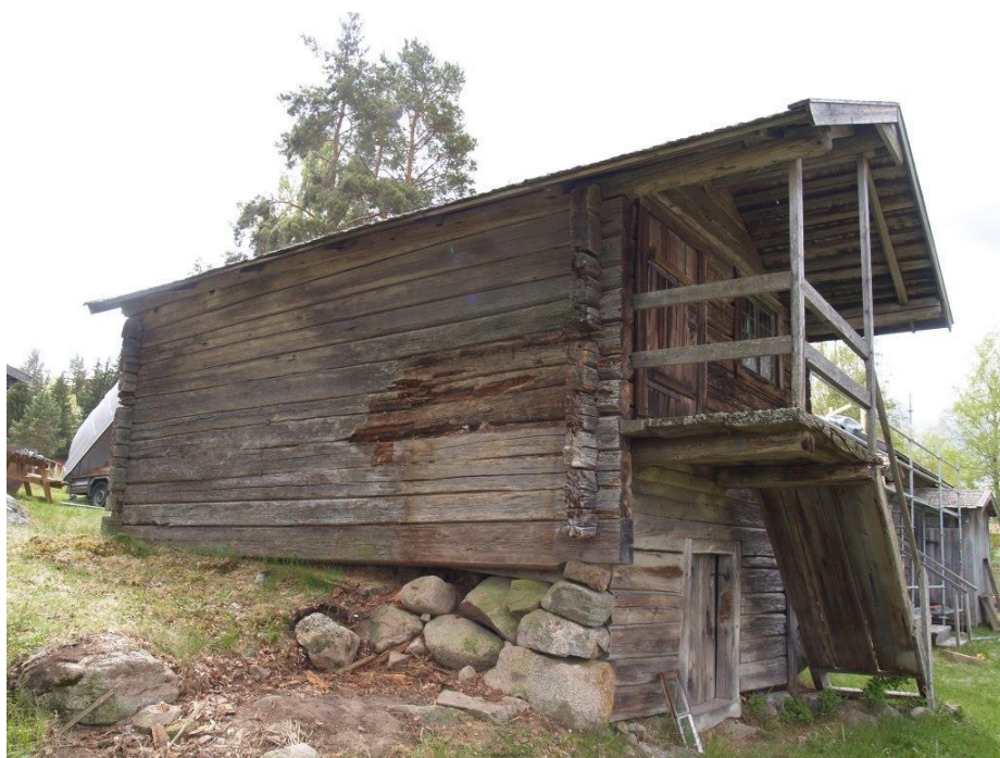
2020-05-28: Dasset på nasstugas norra sida har rivits.
