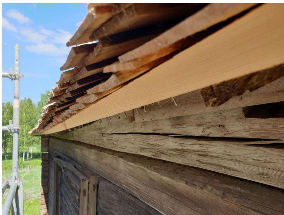
2020-06-22: Nasstugans takfot med droppnäsa på spånen.
