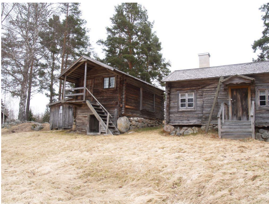
2020-04-08: Nasstugan till vänster och bostadshusets norra del till höger i bild.
