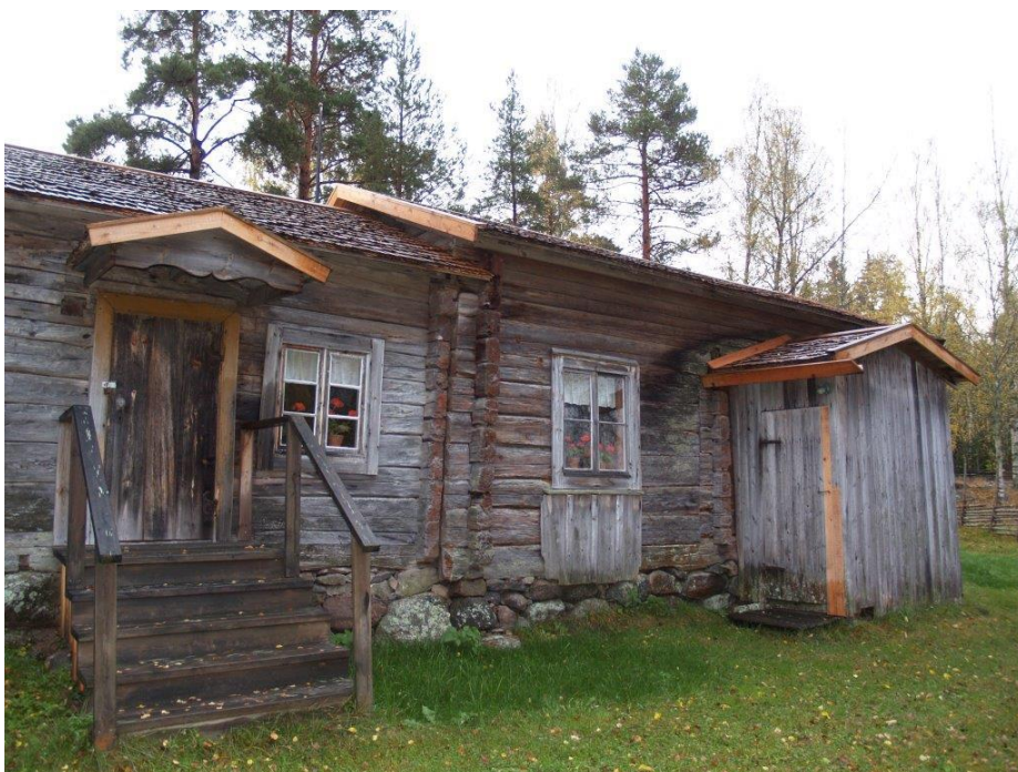
2020-10-07: Slutbesiktning Omlagda spåntak på stuga och farstukur med nyanock- och vattbrädor samt vindskivor.
