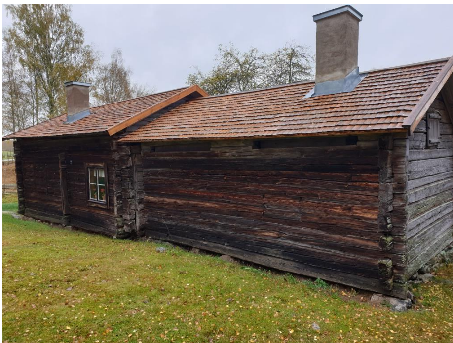
2020-10-07: Slutbesiktning Omlagt spåntak och lagad skorsten.
