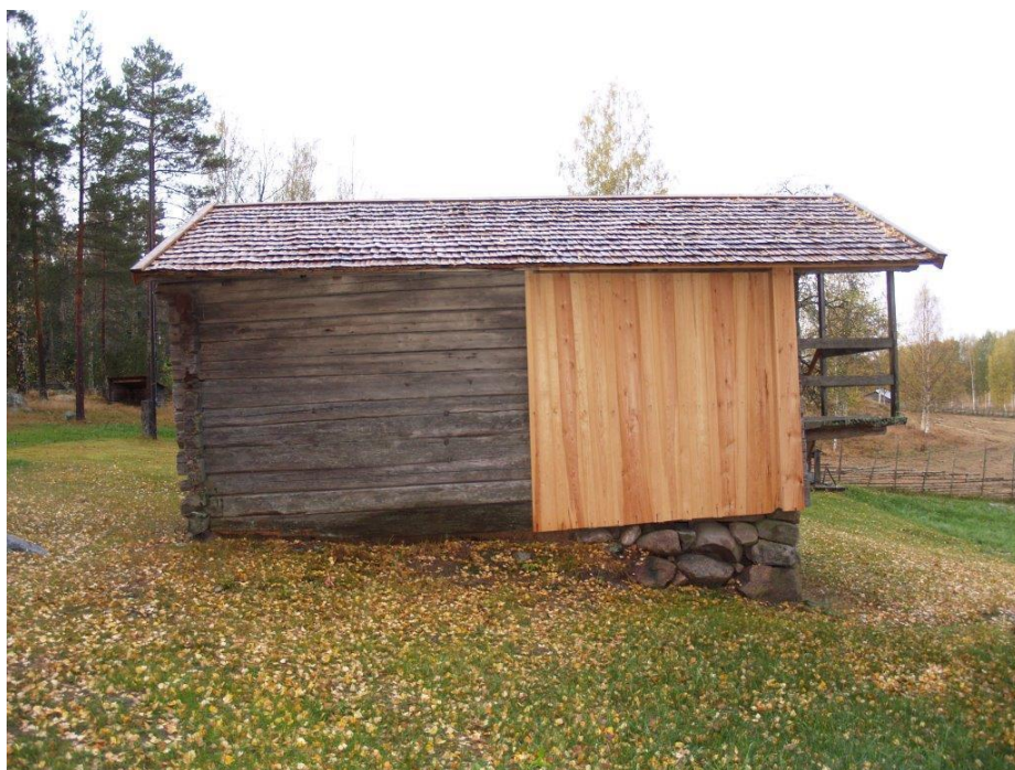
2020-10-07: Slutbesiktning Spåntaket är omlagt och nya vindskivor, vatt- ochnockbrädor har tillförts. Skadorna i timmerstommen är dolda med en panel.
