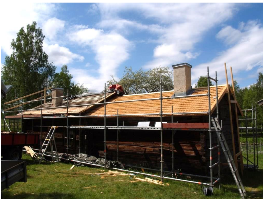
2020-06-09: Omläggningen av spåntaket på den södra stugan under pågående arbete.
