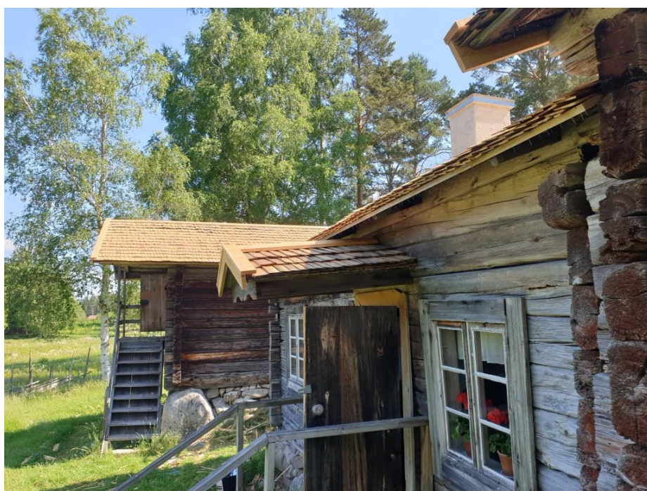
2020-06-22: Skärmtaket har ny täckning av spån.
