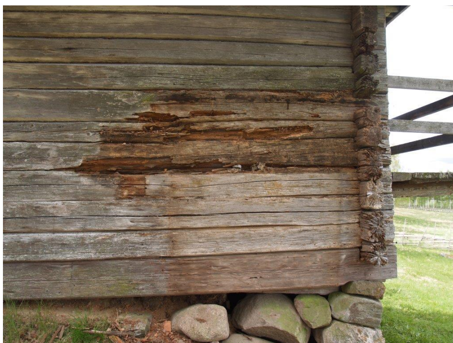
2020-05-28: Rötskadorna är genomgående och timret kan skarvas men inte halvsulas. Det betyder att det nya timret skulle bli synligt på insidan. Vårt förslag blev att spika en panel på halva väggen, från knutkedjan och förbi skadan. Då påverkas inte upplevelsen inifrån och spåren med dymlingar från den äldre tillbyggnaden blir synliga.
