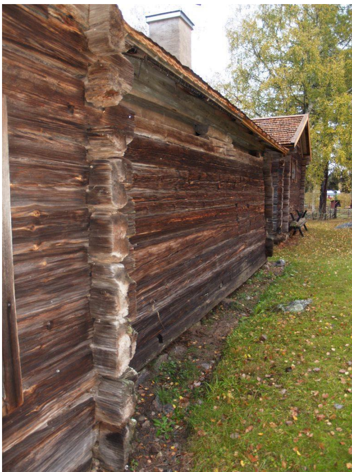
2020-10-07: Slutbesiktning Syllen har frilagts genom att jorden närmast har grävts undan.
