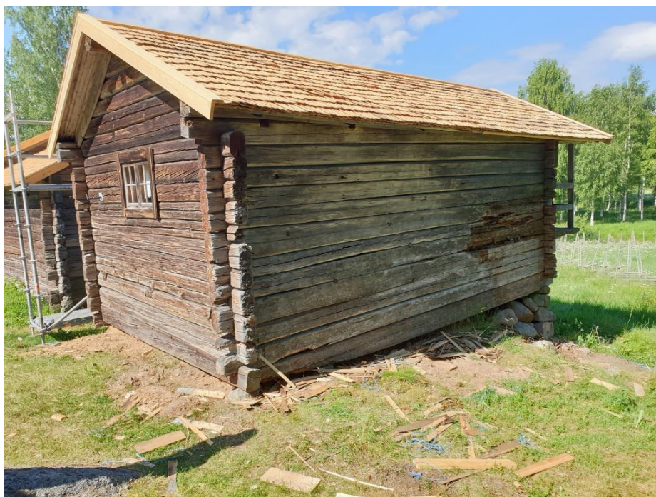
2020-06-22: Nasstugans tak efter omläggning av spåntaket. Det återstod att klä in skadorna på väggen med en panel.
