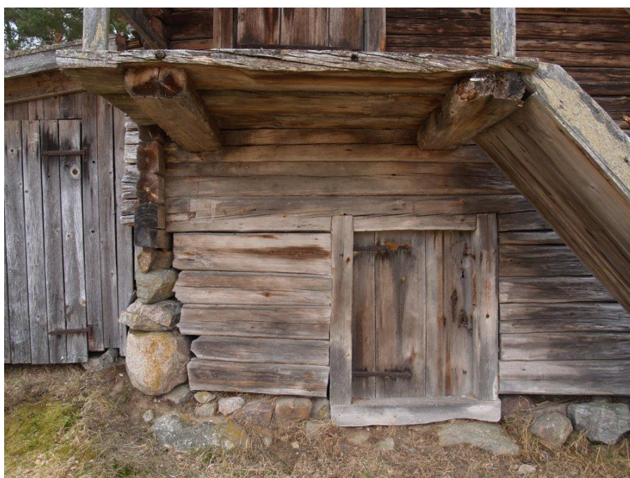
2020-04-08: Ingång till jordkällaren via gaveln.
