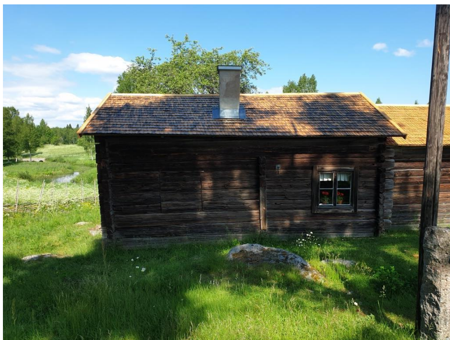
2020-06-22: Taket på södra stugan efter omläggning.
