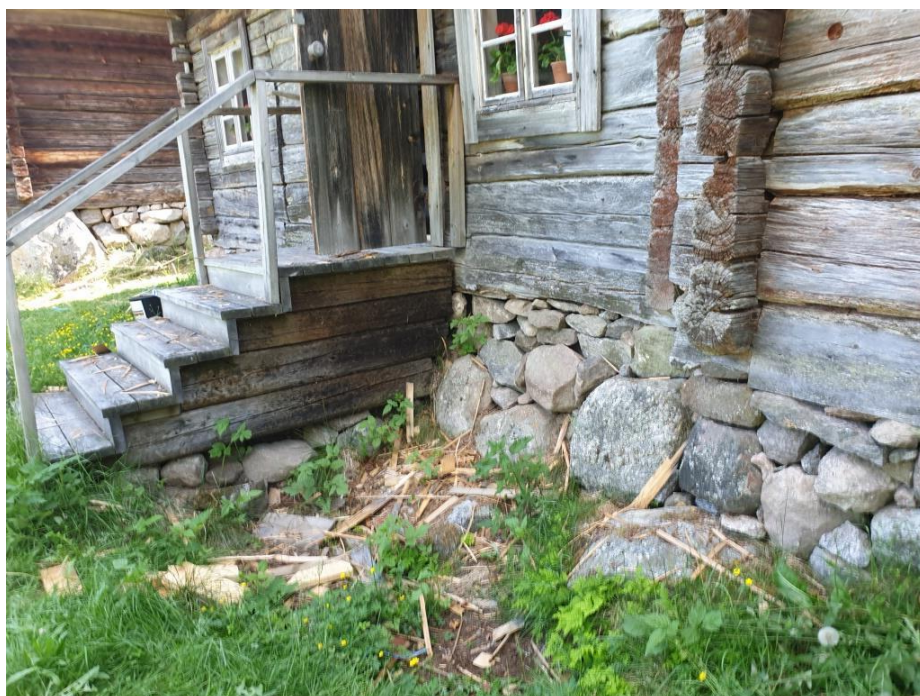
2020-06-22: Stengrunden har justerats och knutkedjan vilar nu på hörnstöd av sten.
