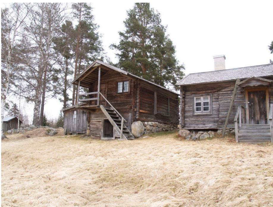
2020-04-08: Nasstuga innan åtgärd.
