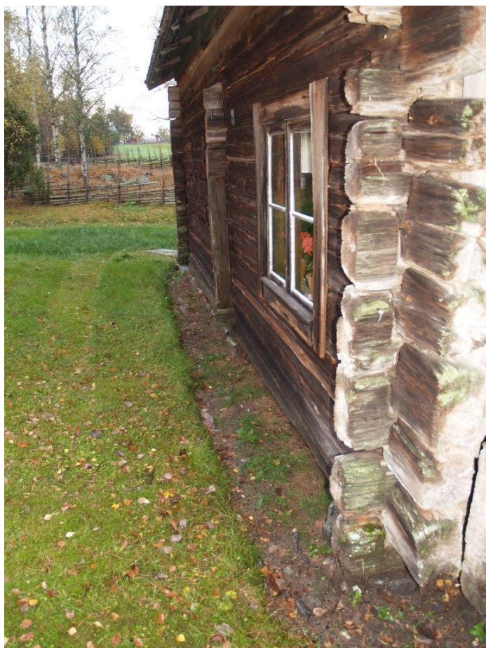
2020-10-07: Slutbesiktning Syllen har grävts fri och kan nu torka bättre.
