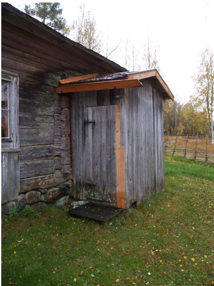
2020-10-07: Slutbesiktning Farstun med lagad panel och ny hängränna. En ny rännkrok tillverkades och sitter närmast väggen. En gavel i rännan gör att vattnet inte ska gå bakvägen in mot timret. Den sitter med distans så att det inte ska låsas fukt mot timret.
