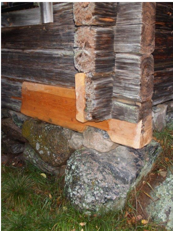
2020-10-07: Slutbesiktning Lagning av syll.
