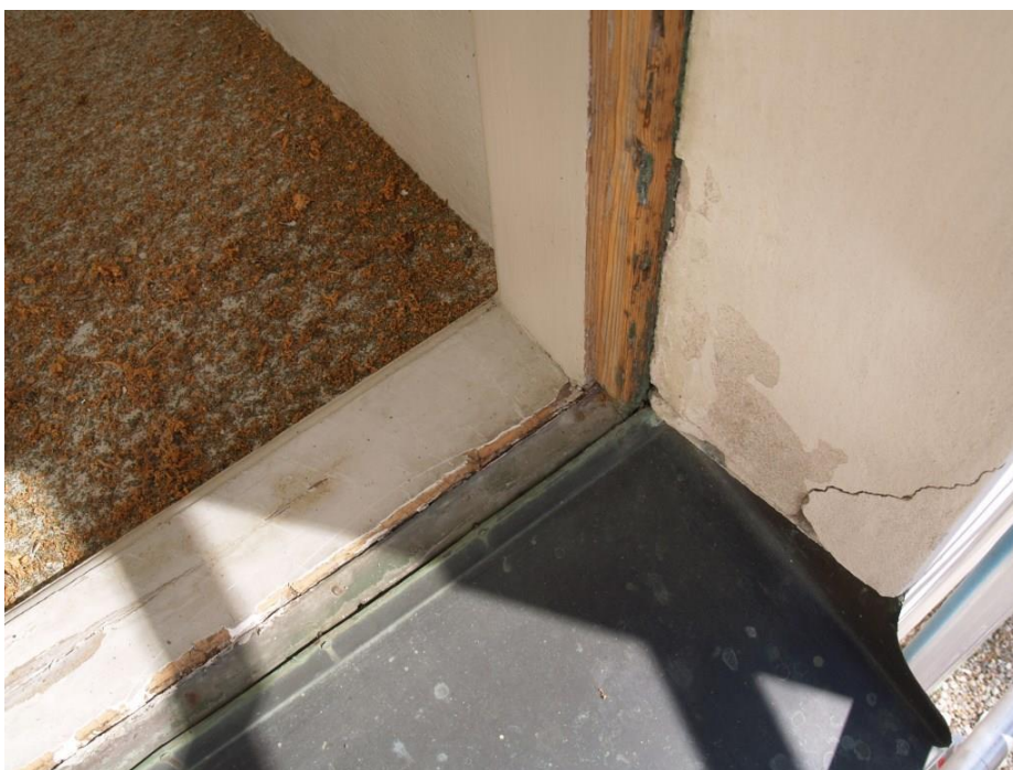
2019-04-15: Droppbleck nedtill i karmen. I tornet är blecket av koppar medan de på långsidorna är av målad plåt.
