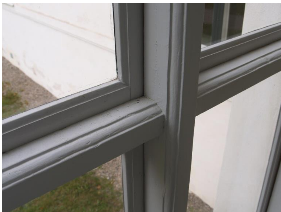
2020-09-15: Slutbesiktning Innerbågarna ska återmonteras.
