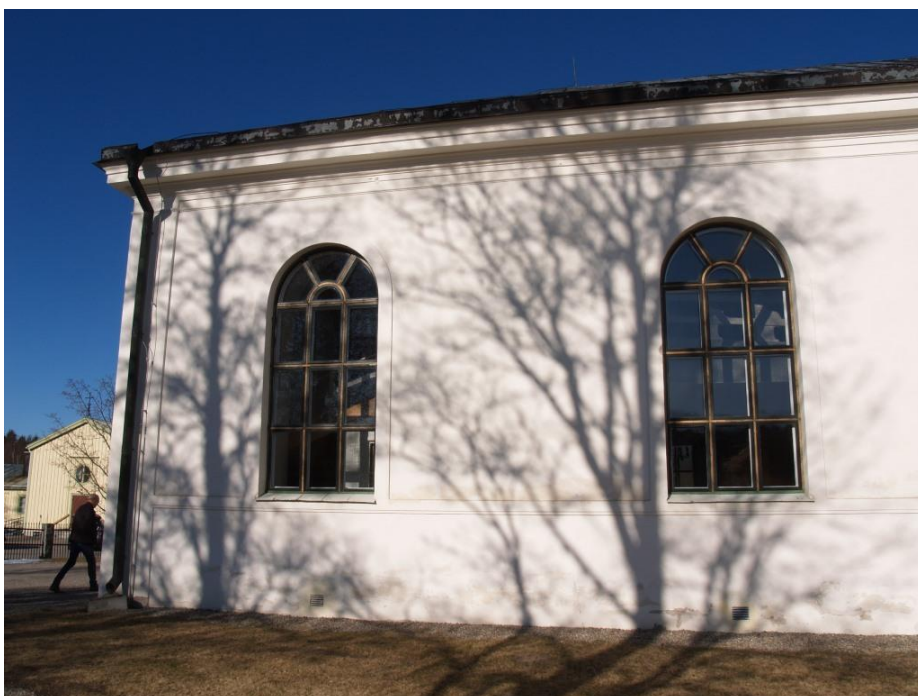
2020-03-19: Mot söder hade fönsterbågarna suttit inne sedan jul.
