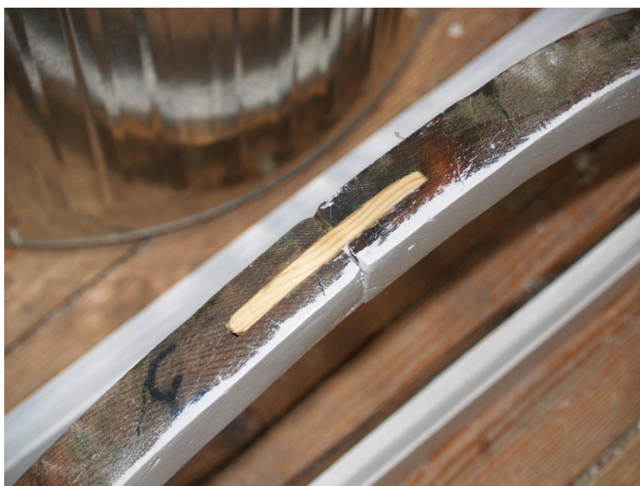
2019-04-24: Trätapparna som håller bågarna samman byttes ut.
