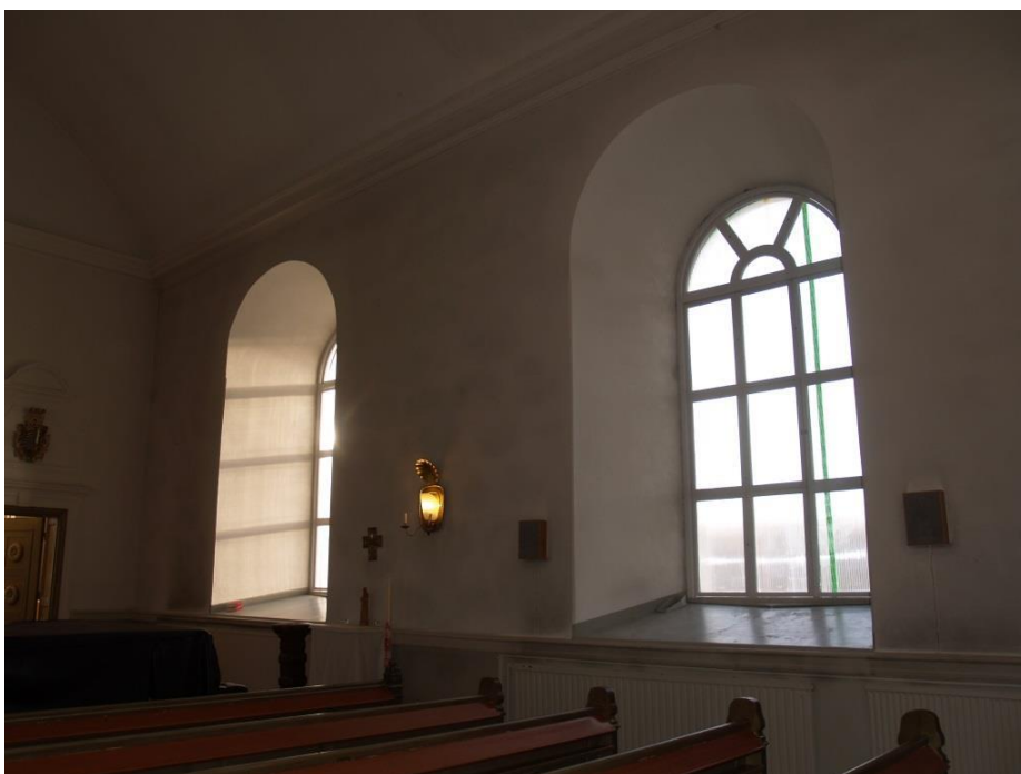
2019-11-15: Innerbågarna har satts in i öppningarna medan kanalplasten fortfarande är kvar på utsidan.
