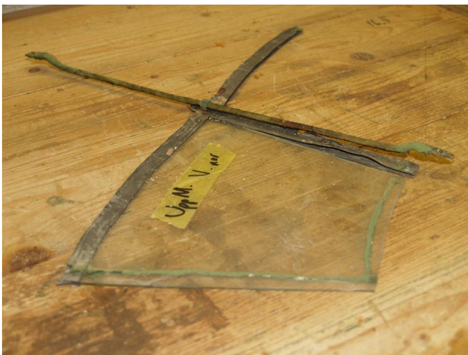
2019-04-24: Enstaka fönster hade kvar blyspröjsar och stormjärn.
