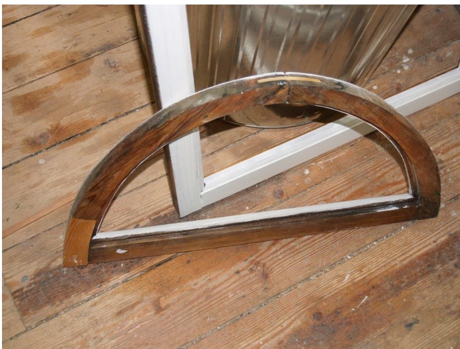
2019-04-24: Nygjord lagning av båge.
