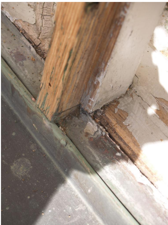
2019-04-15: Det är dubbla plåtar. Troligen finns den äldre plåten kvar under den senare kopparplåten.
