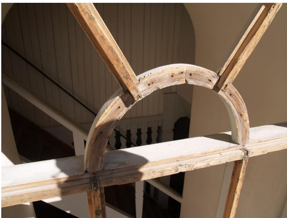
2019-04-15: Den övre delen av fönsterkarmen i tornet.
