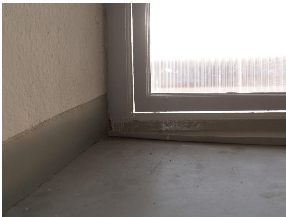
2019-11-15: Bågarna var verkstadstorra så gliporna mellan båge och karm blev extra stora. Vi bestämde oss för att dreva med linsnöre och sedan tejpa med fönstertejp.
