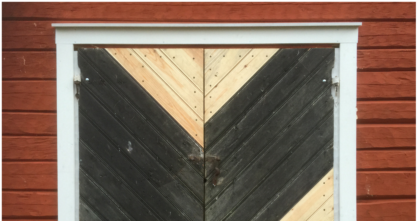
Portarna och dörren renoverades. Vi hyvlade fram likadan panel som fanns på dörrarna och bytte ut de delar som var skadade
