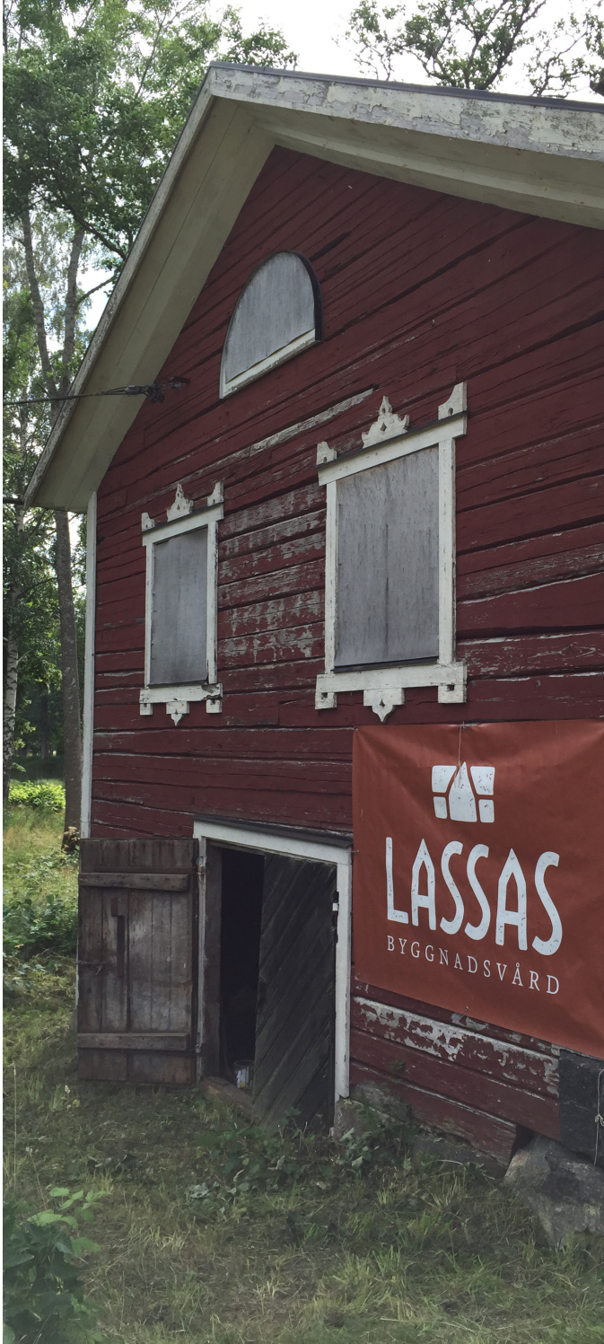
Gaveln innan renoveringsarbetet startade.
