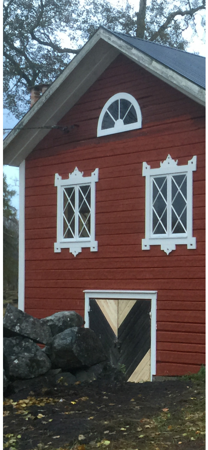
Den renoverade gaveln där 22 timmervarv byttes ut (nymålat).
