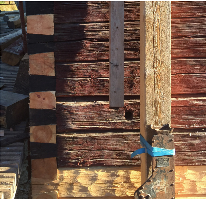
De nya timmerstockarna anpassas till de befintliga timmerstockarna på långsidan.
