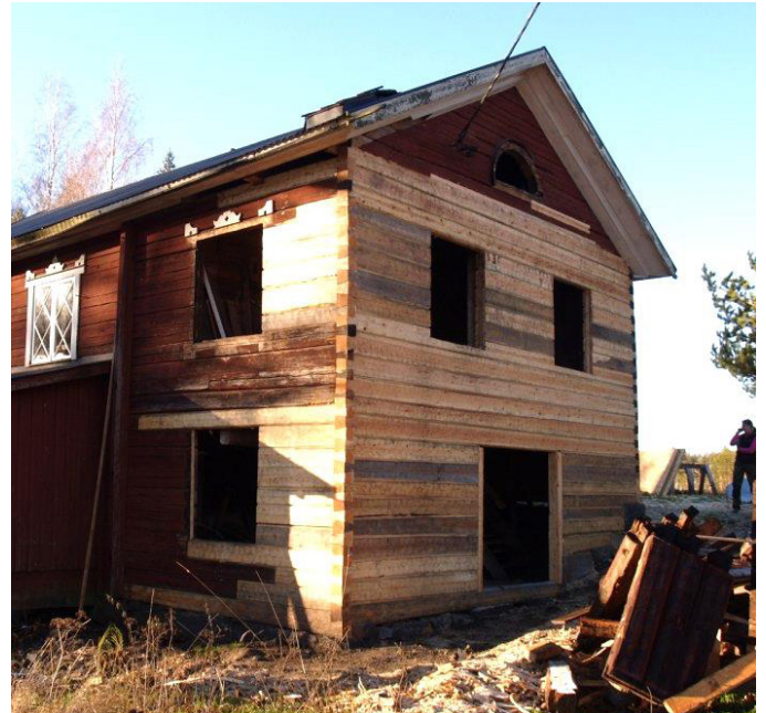
Timmerrenoveringen är färdig.
