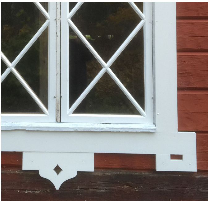
Nya fönsterbågar och nytt foder.
