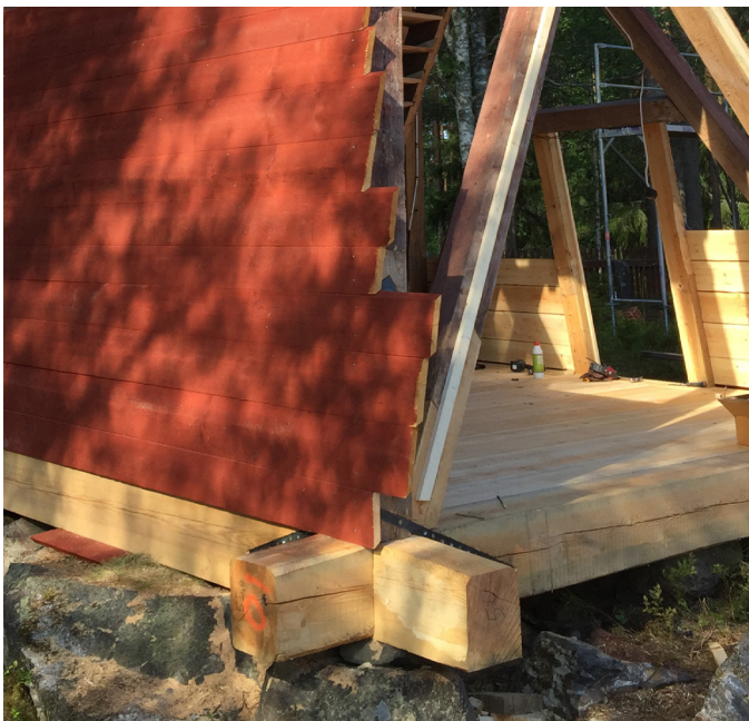
Den rödtjärade ramsågade panelen spikas med klippspik.
