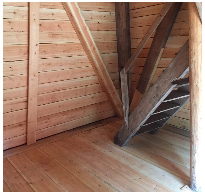
Det nya golvet är på plats inne i klockstapeln.
