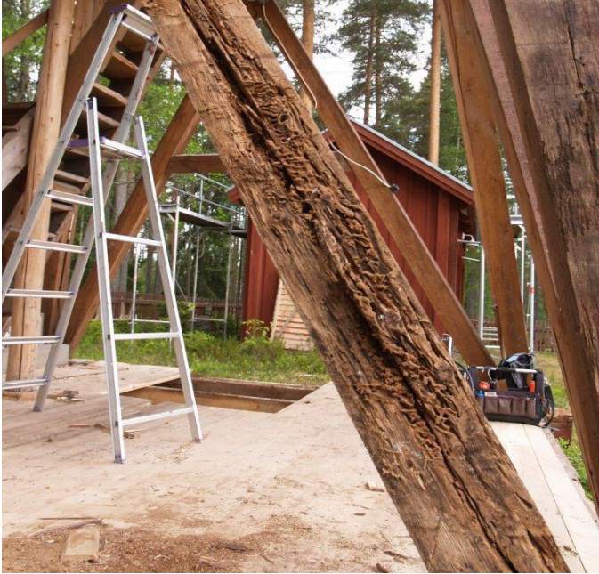
Ett myrbo i ett av de bärande timmerkryssen.
