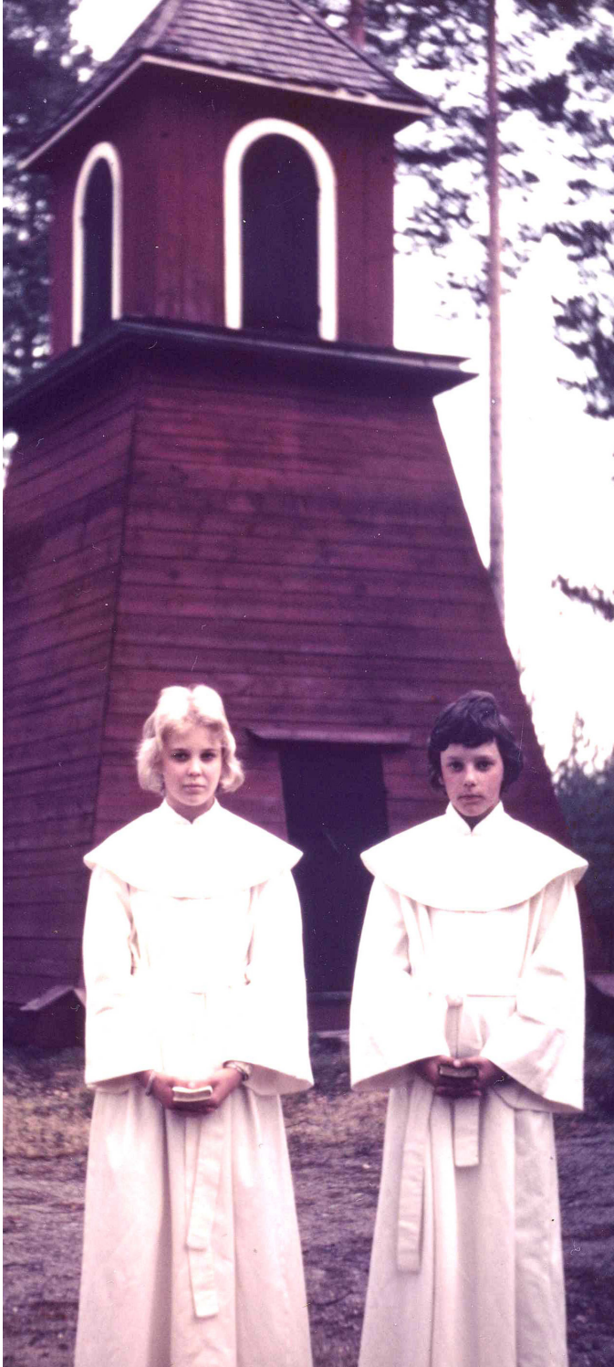
För att kunna utföra rekonstruktionen studerades gamla foton, här ett foto från 1973
