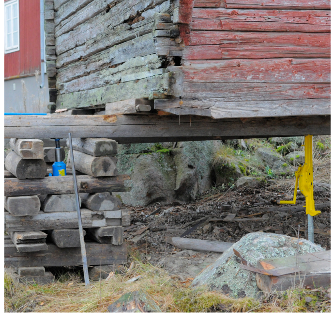
Härbret har lyfts och ställts på pallning för att kunna byta härbreunderredet.
