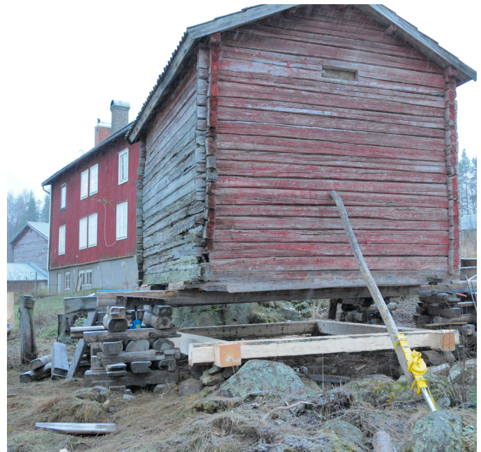
Det nya underredet är på plats.
