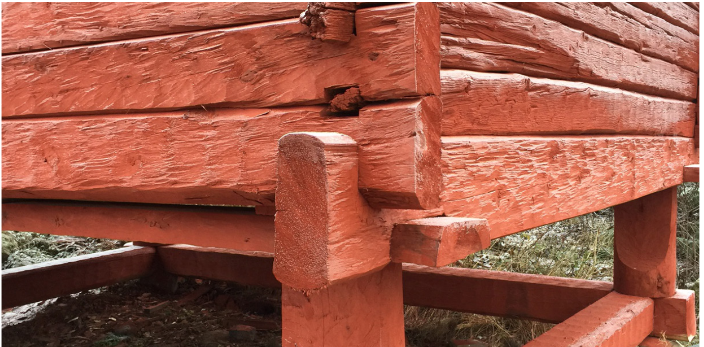
Närbild på det mest skadade hörnet när det är renoverat
