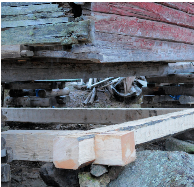
Det nya underredet monteras.
