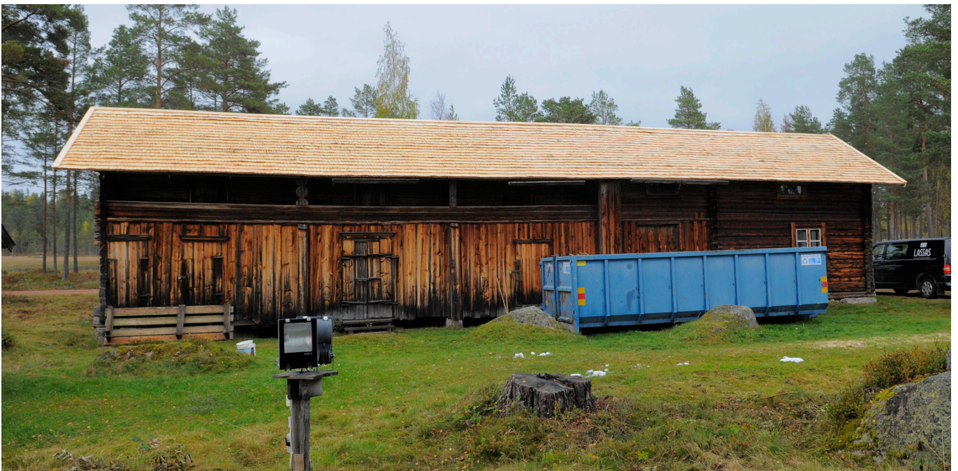
Det färdiga taket med handspäntat takspån.
