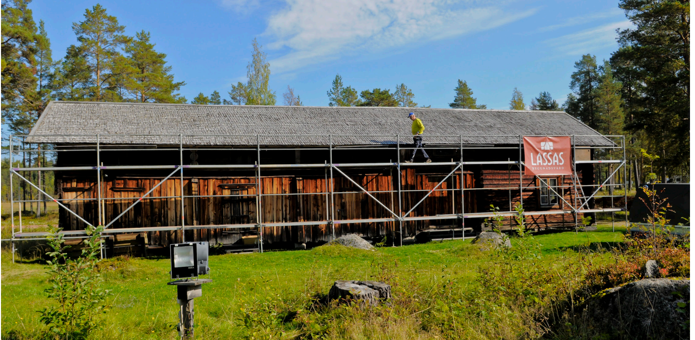
Dränglängans tak före renovering.
