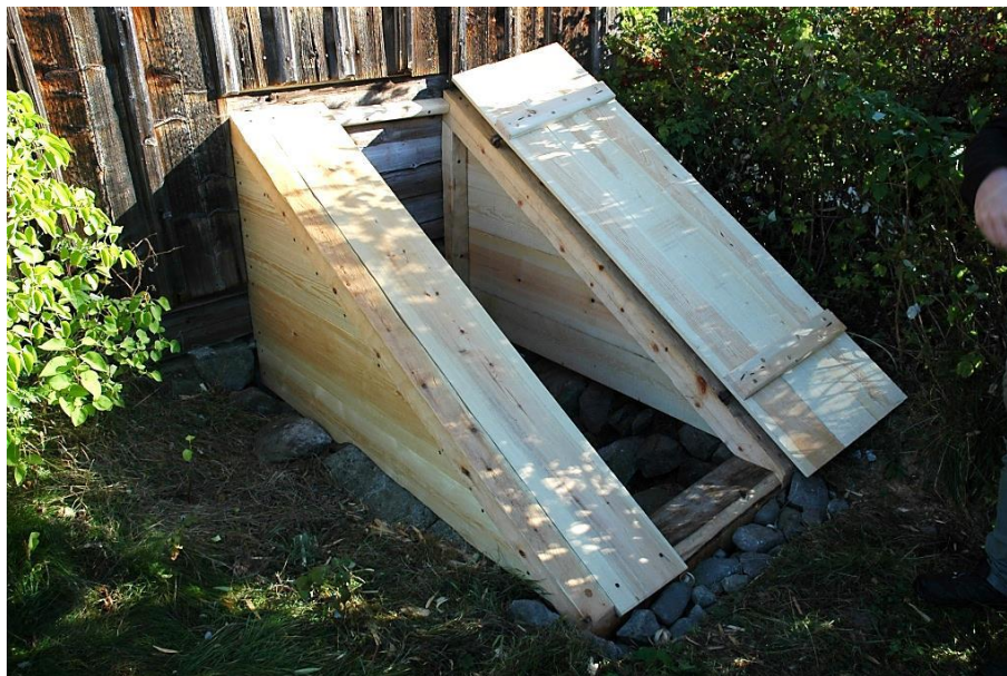
Figur 18. Källarsvalen vid "Yst på gårdens" södra gavel efter rekonstruktionen. Foto från sydväst. Daniel Olsson, Länsmuseet Gävleborg 2016-09-12.
