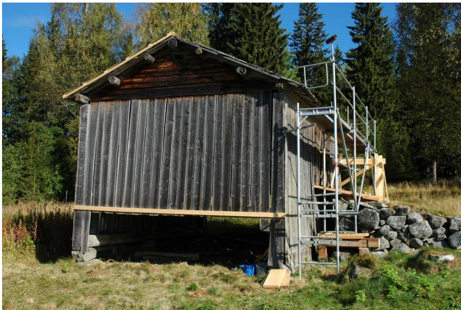
Figur 13. Vagnslidret från söder under renoveringen. Foto: Daniel Olsson, Läns museet Gävleborg 2016-09-05.
