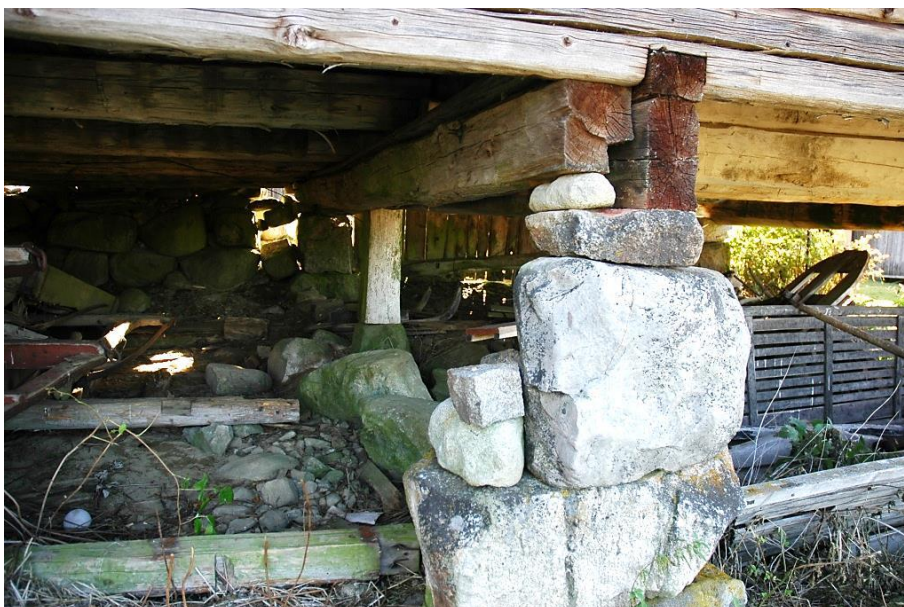
Figur 17. Detalj av åsarna under stallet efter renoveringen. Jämför med figur 11. Foto från nordöst, Daniel Olsson, Länsmuseet Gävleborg 2016-09-01.
