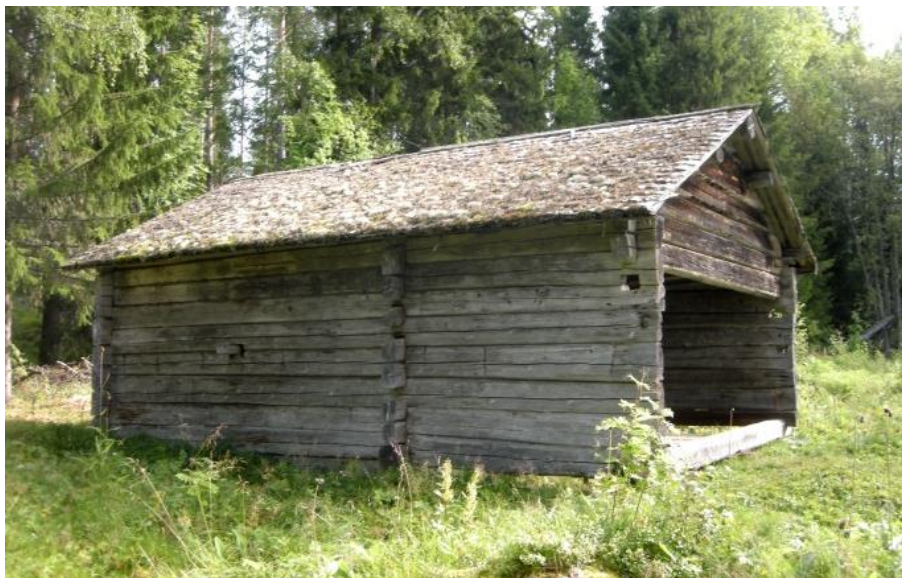
Figur 6. Bastun innan renoveringen. Foto från sydväst, Daniel Olsson, Läns- museet Gävleborg 2015-09-01.
