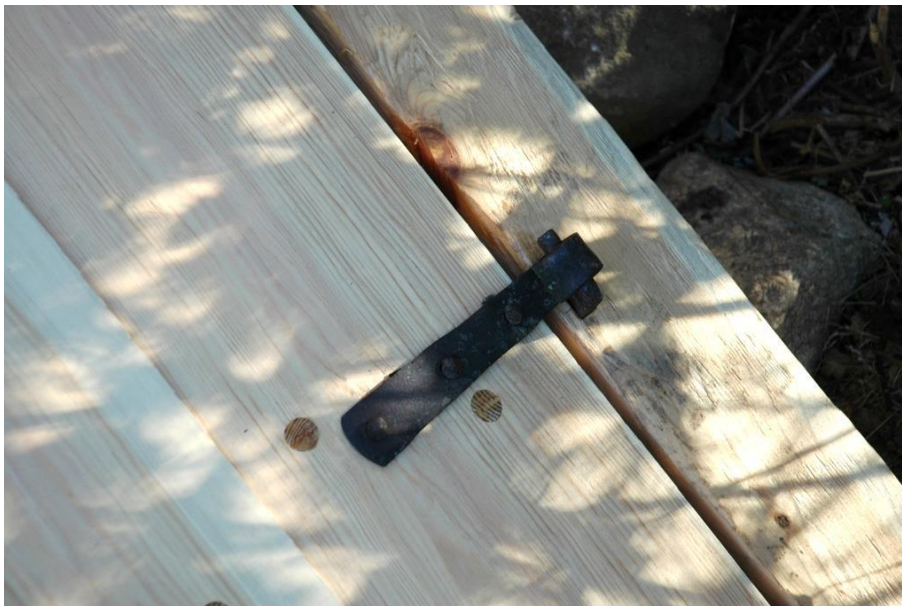
Figur 20. Detalj av dörren i källarsvalen söder om "Yst på gården" som är sammanfogad med tränaror och försedd med återanvända gångjärn. Foto från sydväst, Daniel Olsson, Läns museet Gävleborg 2016-09-12.
