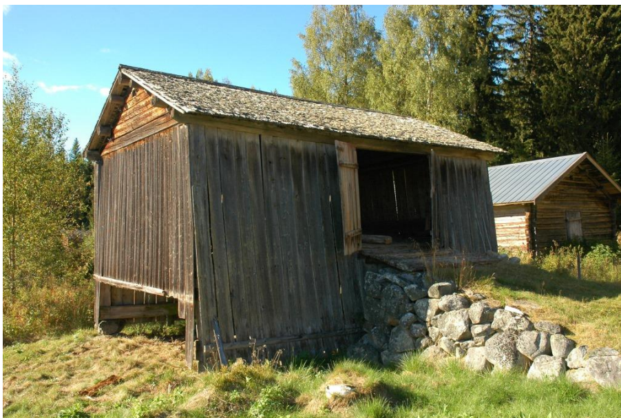
Figur 8. Vagnslidret innan påbörjad renovering. Foto från söder, Daniel Olsson, Länsmuseet Gävleborg 2016-08-23.
