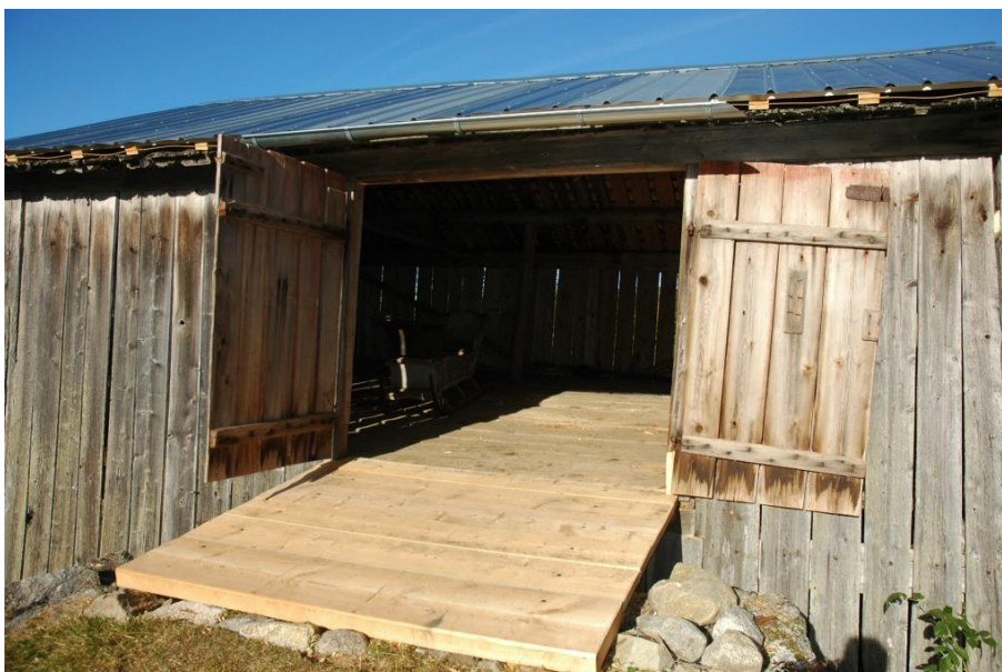
Figur 14. Vagnslidret efter tillverkning av ny körbrygga av trä samt byte av takmaterial. Foto från öster, Daniel Olsson, Läns museet Gävleborg 2016-09-12.
